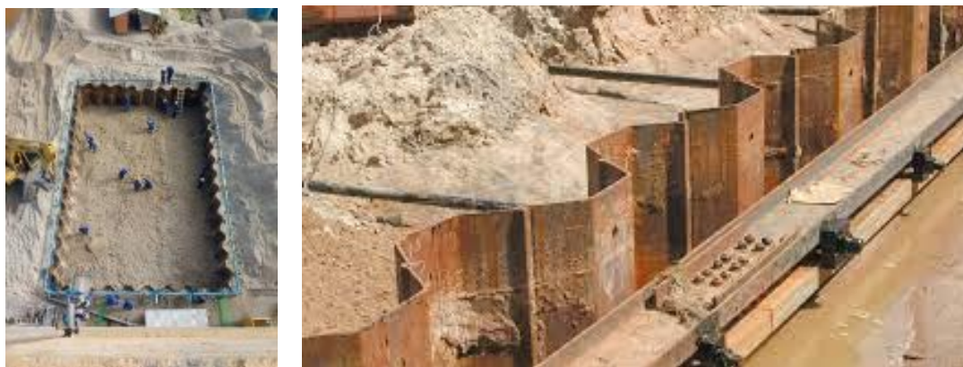
Figura 19 - Estaca Prancha
