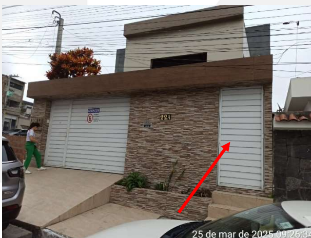
Foto 20 – Segundo acesso ao pavimento
