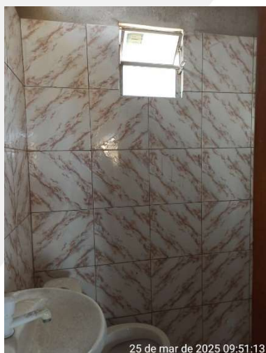
Foto 19 – Segundo banheiro no pavimento
