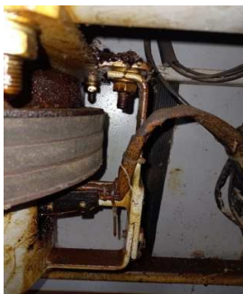
Fig. 05: Situação atual, micro sem sensor.
