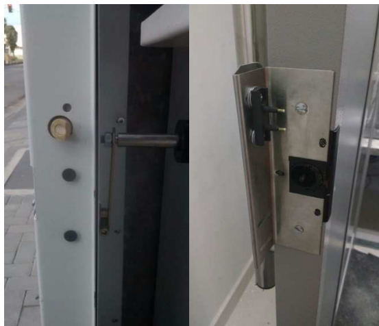
Fig. 04: Situação ideal, sistema de fecho com trincado.
