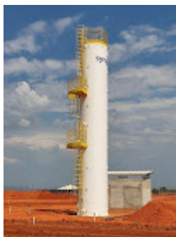
IMG-20210929-WA0075 (002).jpg 132K
