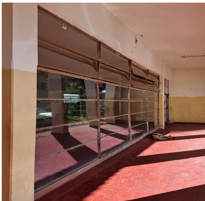
Figura 9- Estrutura metálica com vidro a ser removida
