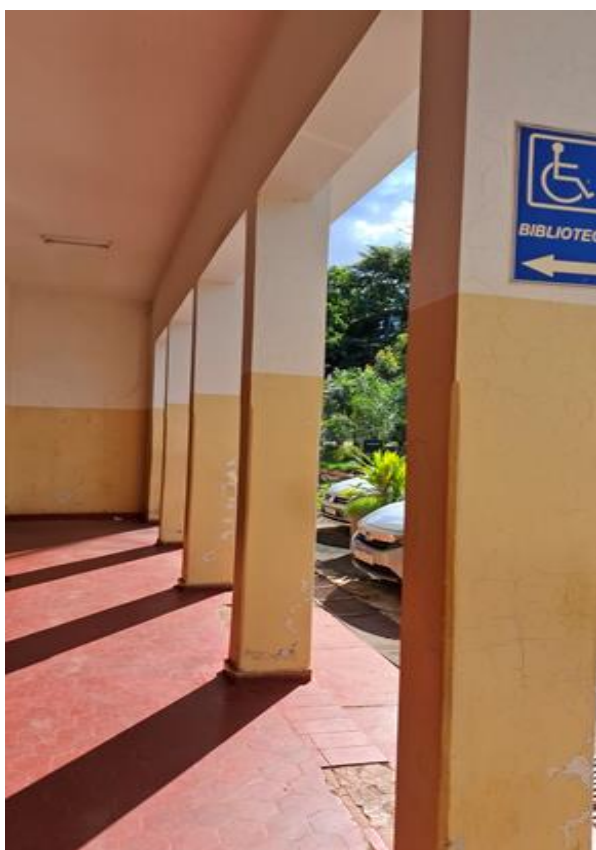
Figura 12- Local a ser instalado Vidro temperado
