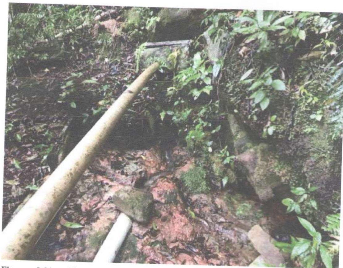
Figura nº 01 – Afloramento Superficial de Água em rochas, que abastece o Instituto Federal Farroupilha Campus de Jaguari/RS.
