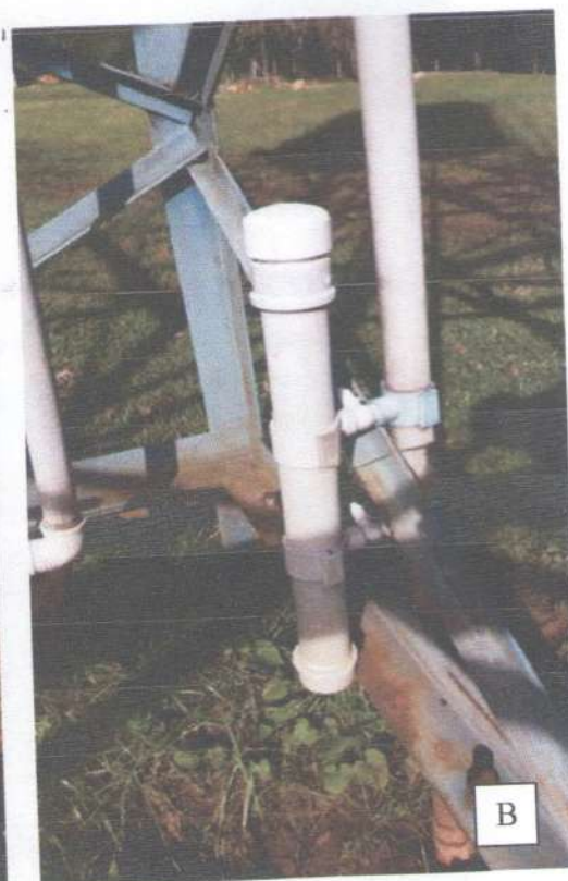
Figura nº 09 – Sistema de Abastecimento de água. (A) e (B) Dosador de cloro existente no reservatório central do Campus.
