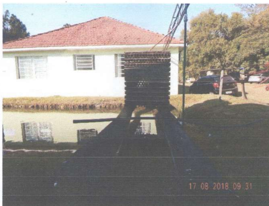
Figura nº 11 – Lagoa impermeabilizada – Destilaria. (A) e (B) Lagoa de armazenamento de água para resfriamento do sistema interno da destilaria.
