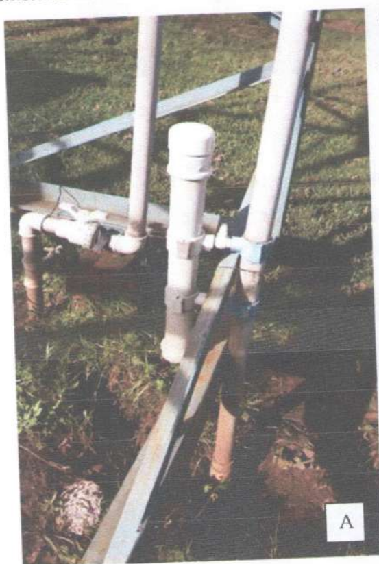
Figura nº 09 – Sistema de Abastecimento de água. (A) e (B) Dosador de cloro existente no reservatório central do Campus.
