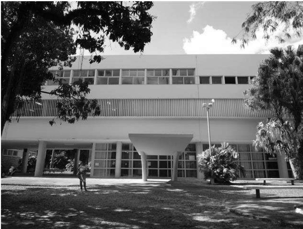
04 - Acesso coberto do Foyer e pilares revestidos em pastilhas. Nesta imagem teríamos quatro descidas aparentes.
