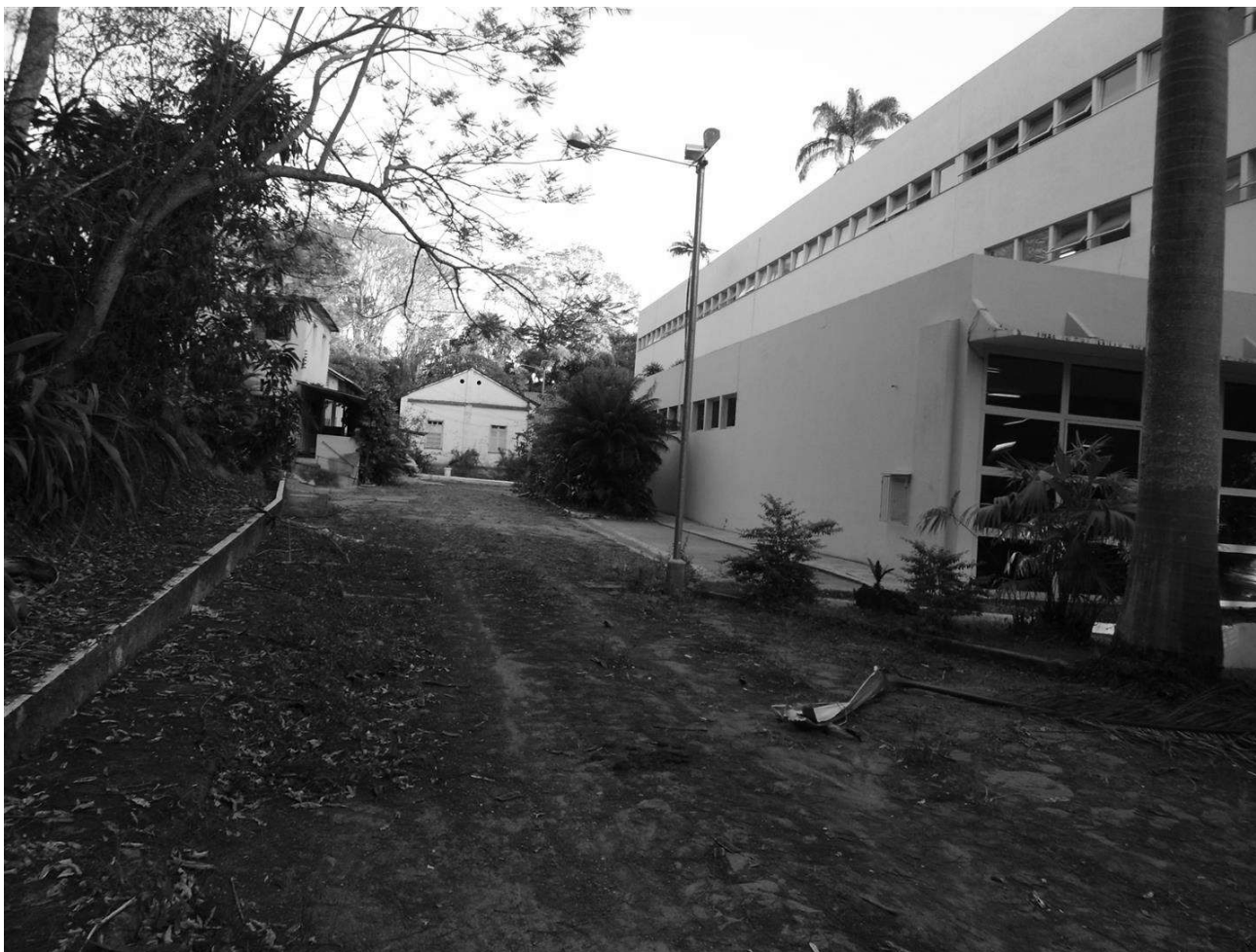
05 - Fachada posterior - local indicado no projeto para a instalação das condensadoras de climatização.
