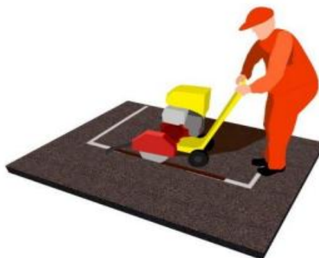
Figura 2 - Corte e remoção do revestimento asfáltico
