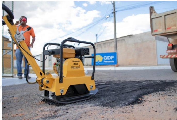
Figura 5 – Compactação da Massa Asfáltica
