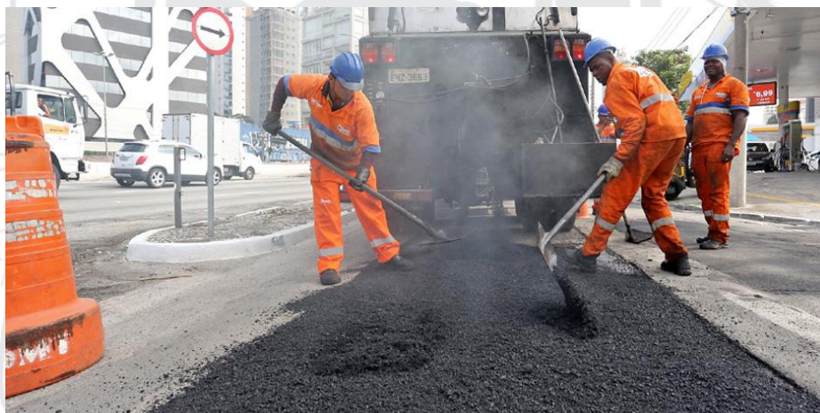
Figura 4 - Espalhamento da Massa Asfáltica
