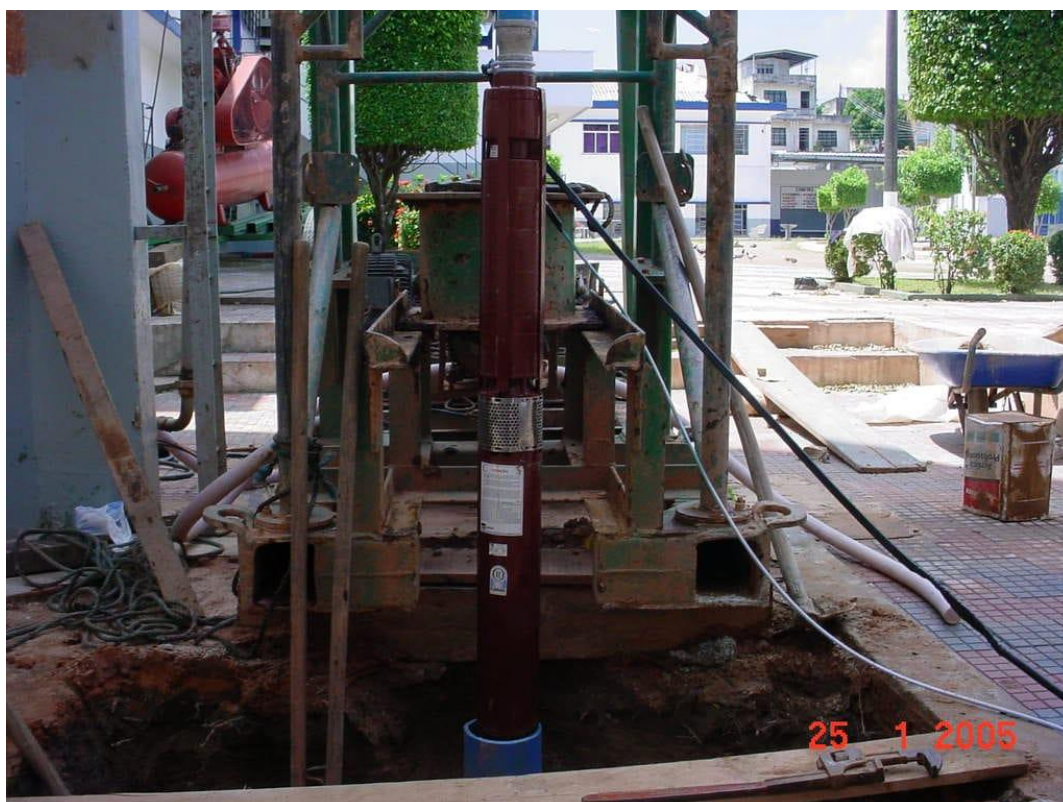
Figura 2: Equipamento de perfuração durante a construção do poço artesiano de 92 metros de profundidade.
