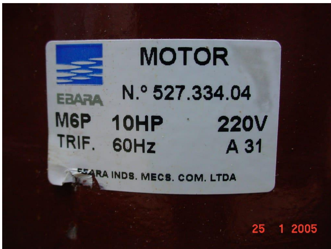
Figura 1: Placa de identificação da bomba original EBARA M6P de 10 HP, 220V, instalada em 2005.
