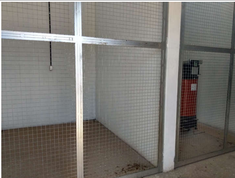
Imagem09- Interior da cabine de transformação com o QGBT da usina solar.
