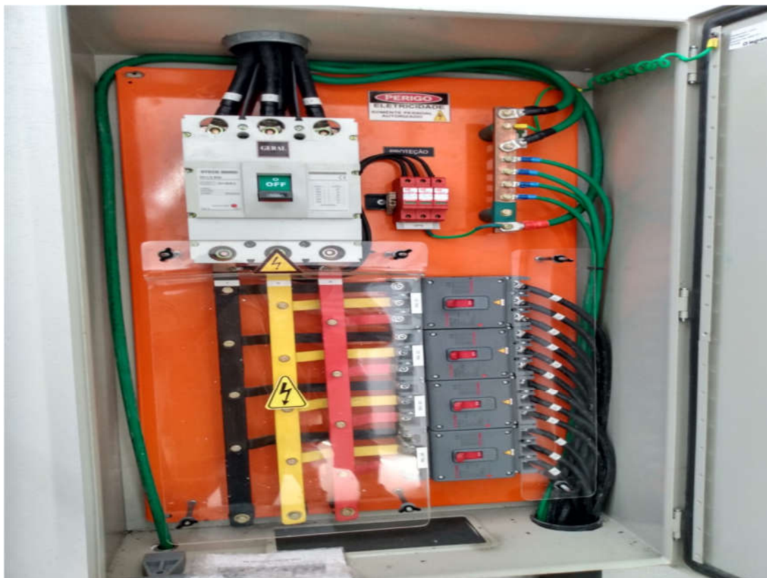
Imagem06- QGBT da usina solar instalado no cubículo do transformador.
