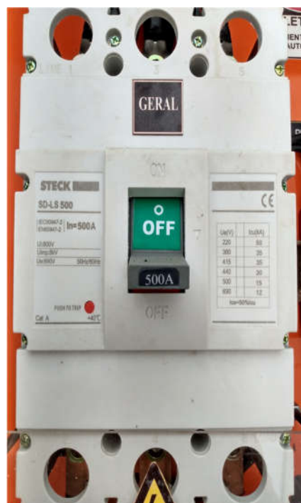
Imagem07- Disjuntor Geral do QGBT do cubículo do transformador da usina solar.
