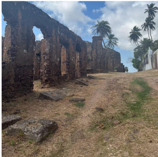
Imagem 05: Ruínas da Rua da Amargura. Fonte: Acervo SECID.
