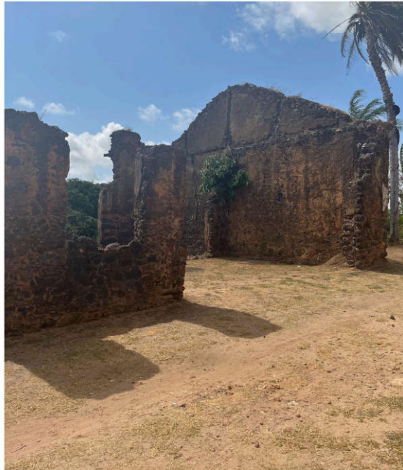
Imagem 10: Ruínas da Rua da Amargura. Fonte: Acervo SECID.
