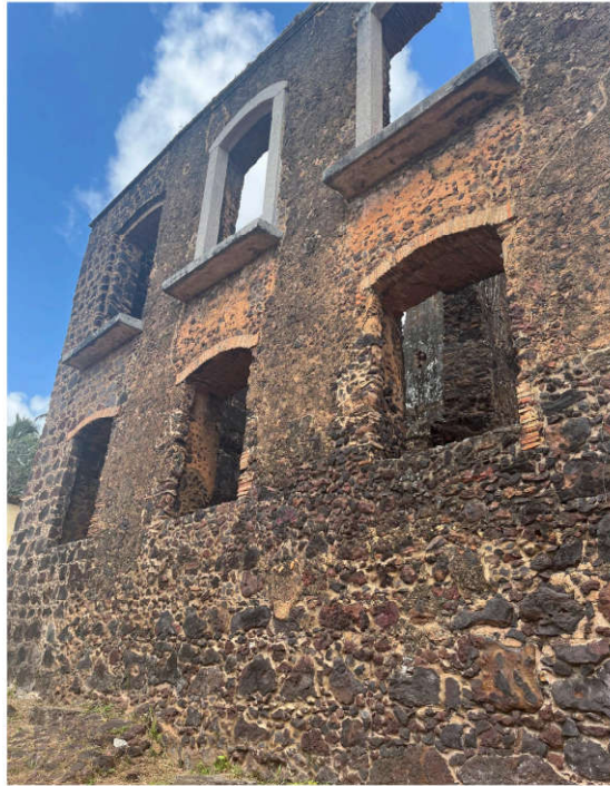
Imagem 06: Ruínas da Rua da Amargura. Fonte: Acervo SECID.
