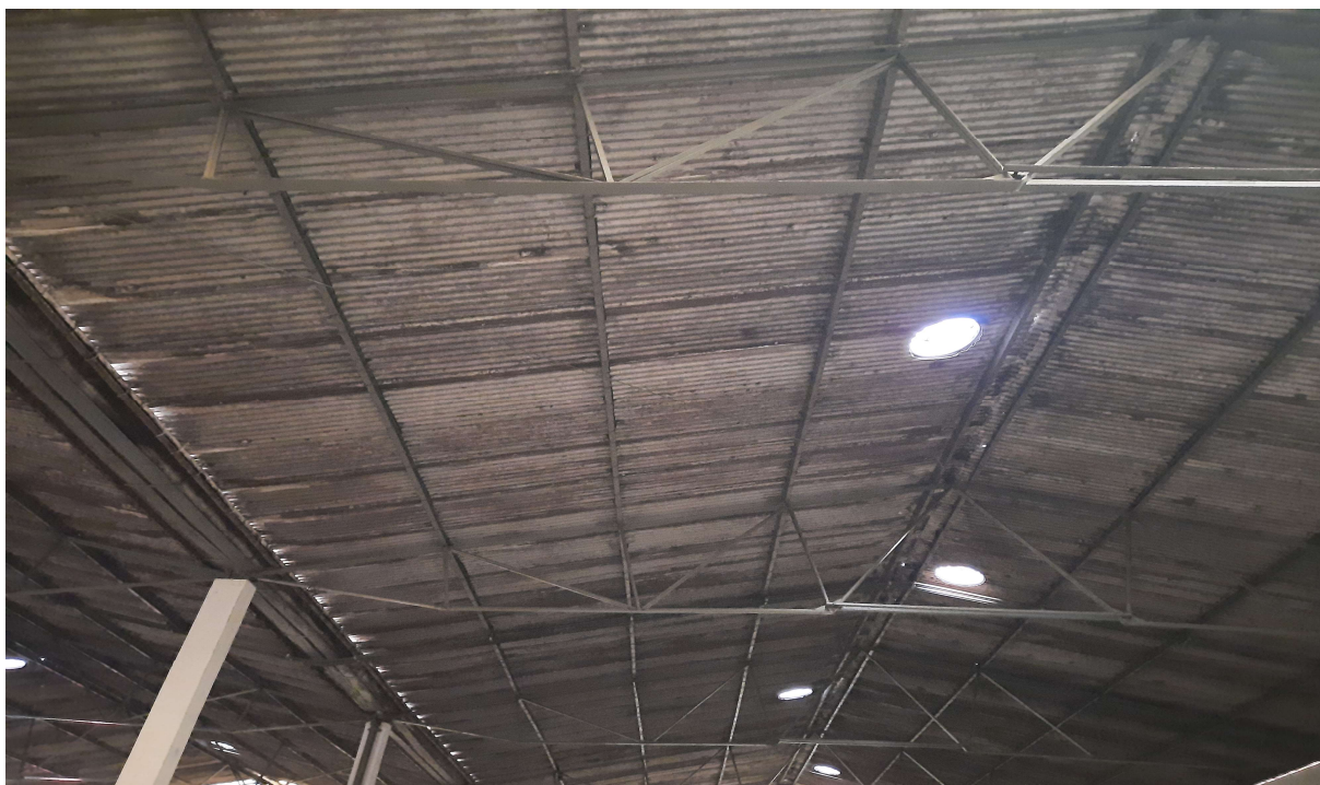
Foto 01 – Recomendamos a execução de reforço na estrutura metálica da cobertura do galpão para instalação dos painéis fotovoltaicos.
