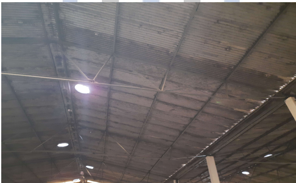
Foto 02 - Recomendamos a execução de reforço na estrutura metálica da cobertura do galpão para instalação dos painéis fotovoltaicos.
