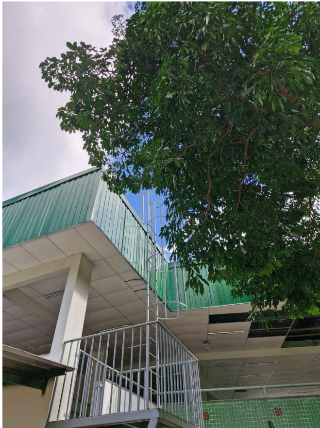
Escada de acesso ao telhado do Bloco II.
