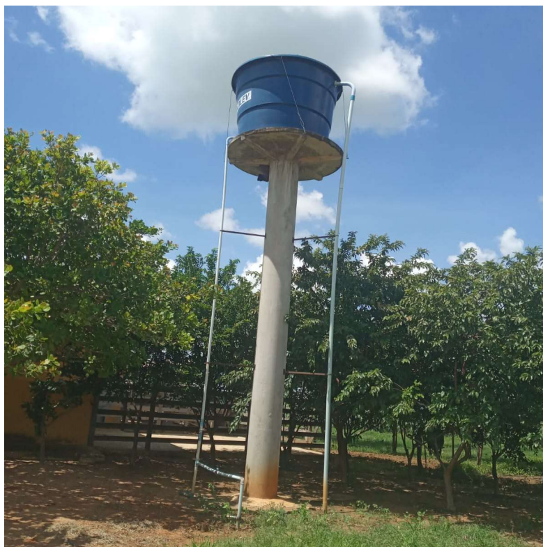
Figura 5. Caixa d'água 3, capacidade 5.000 L, 8,2 metros de altura, sem acesso por escadas, Setor de Bovinocultura. IFRN, 2024.
