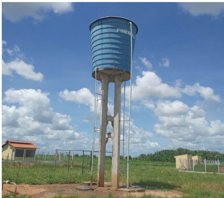
Figura 7. Caixa d'água 5, capacidade 20.000L, 10,2 metros de altura, sem escadas de acesso, próximo da Fábrica de Ração. IFRN, 2024.
