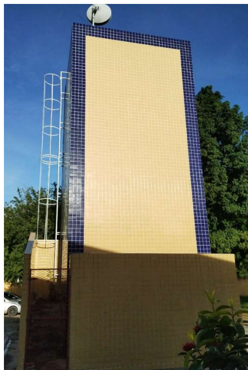
Figura 3. Caixa d'água 1, escada de acesso. IFRN, 2024.
