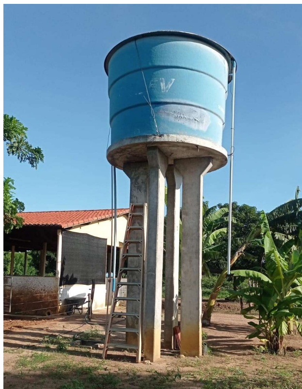
Figura 8. Caixa d'água 6, capacidade 10.000 L, 5,9 metros de altura, sem acesso por escadas, Setor de Suinocultura. IFRN, 2024
