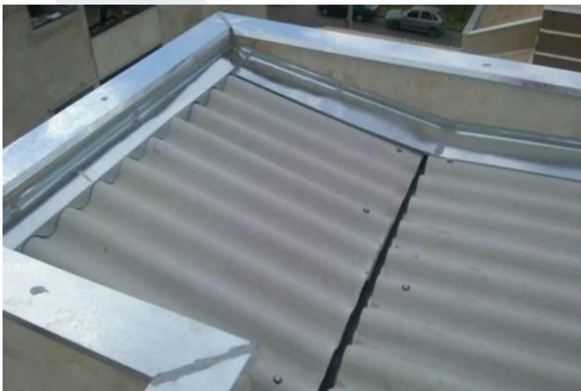
Foto 07 – Exemplo de rufo metálico em cobertura.
