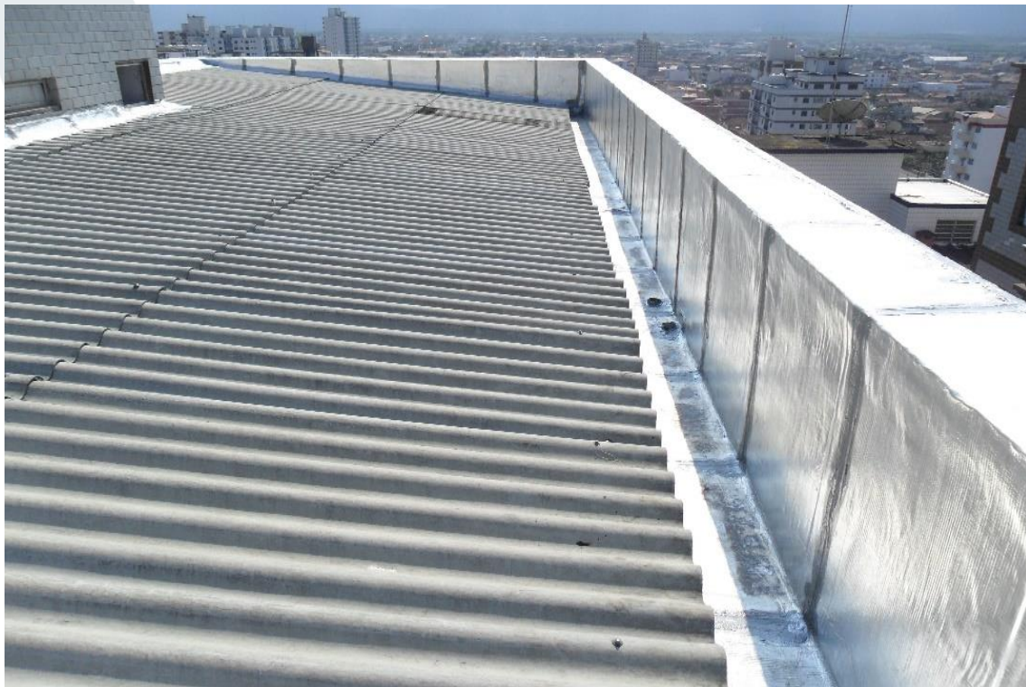
Foto 06 – Exemplo da utilização da manta aluminizada com ligação calha x platibanda
