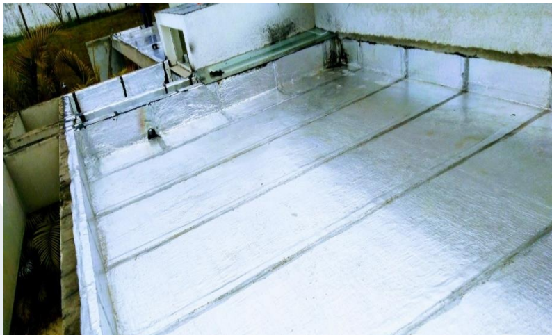
Foto 11 – Exemplo de impermeabilização de laje com manta aluminizada
