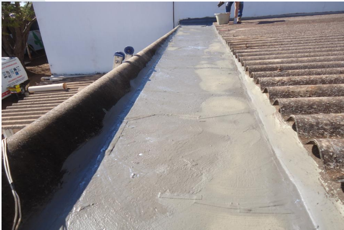
Foto 05 – Exemplo de regularização de inclinação de calhas de concreto.
