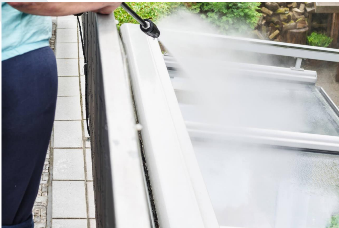
Foto 01 – Limpeza de telhado com lava-jato.
