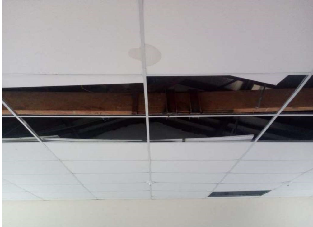
Figura 2 - Flecha no banzo inferior
