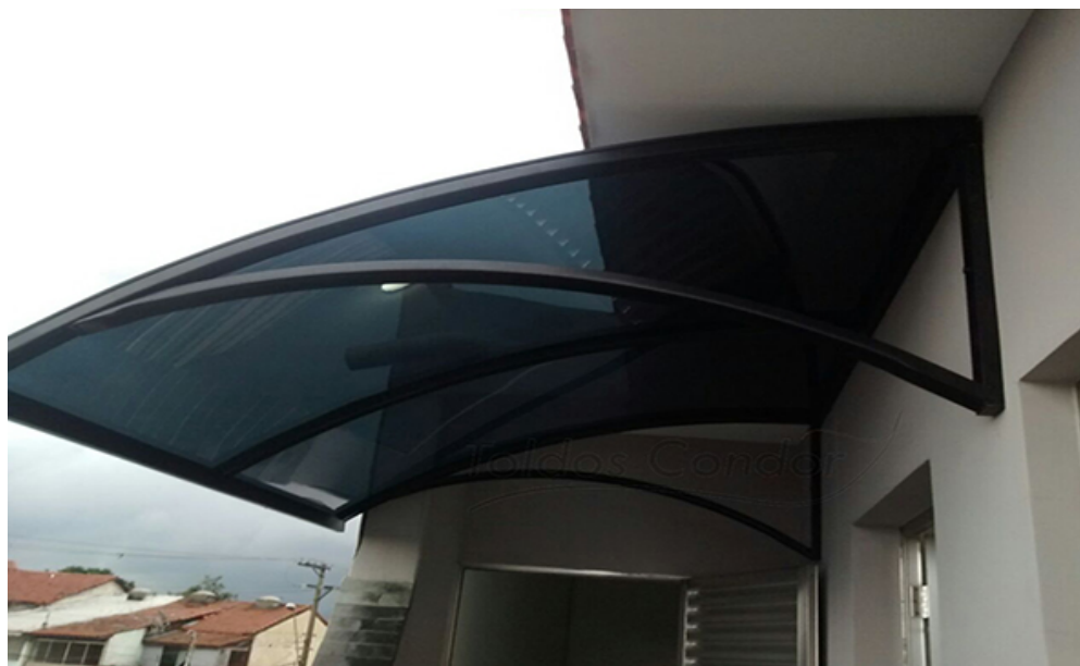
Figura 4: Imagem ilustrativa como referência de toldo fixo com tubo de alumínio e policarbonato compacto fumê.
