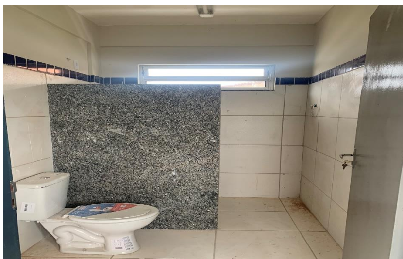
Figura 22 – Detalhe Vestiário do Bloco de Serviço.
