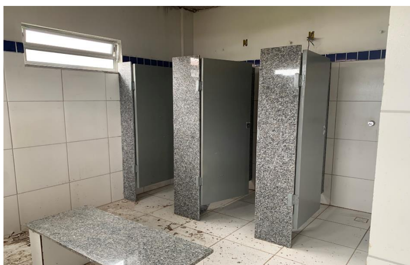
Figura 12- Detalhe do Vestiário da Quadra Coberta.
