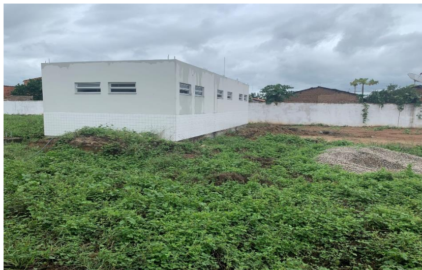
Figura 11- Vista lateral e fundos dos Vestiários da Quadra Coberta.
