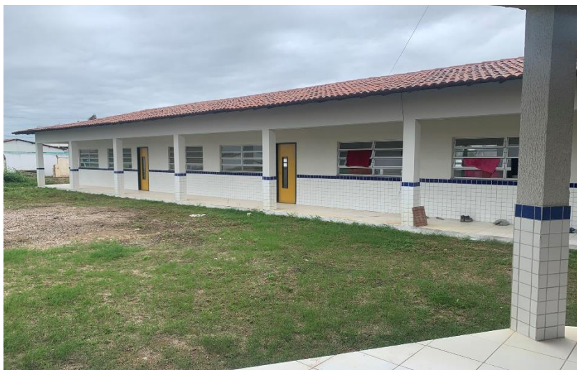
Figura 5 - Vista fachada frontal lateral esquerda do Bloco Pedagógico.
