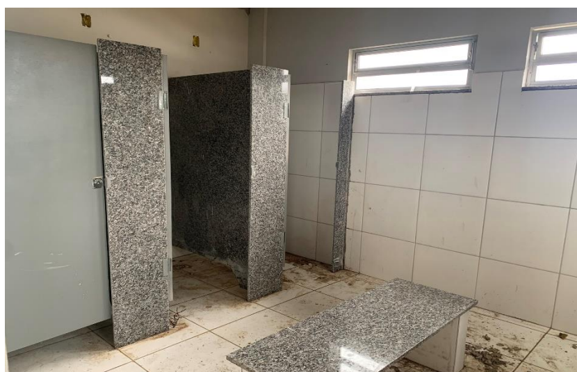
Figura 13 - Detalhe do Vestiário da Quadra Coberta.
