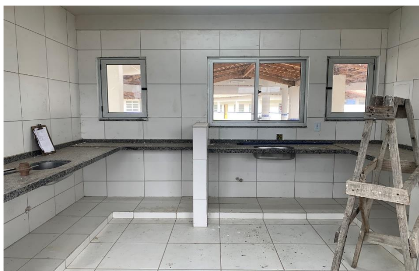
Figura 21 - Detalhe da Cozinha – Bloco de Serviço.
