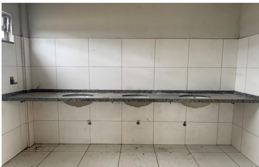
Figura 14 - Detalhe do Vestiário da Quadra Coberta.
