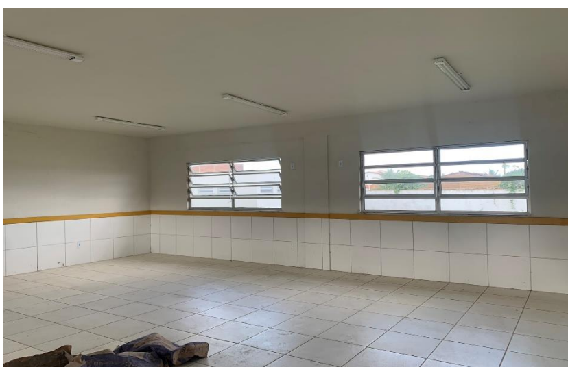
Figura 15 – Detalhe Sala de Aula do Bloco Pedagógico.
