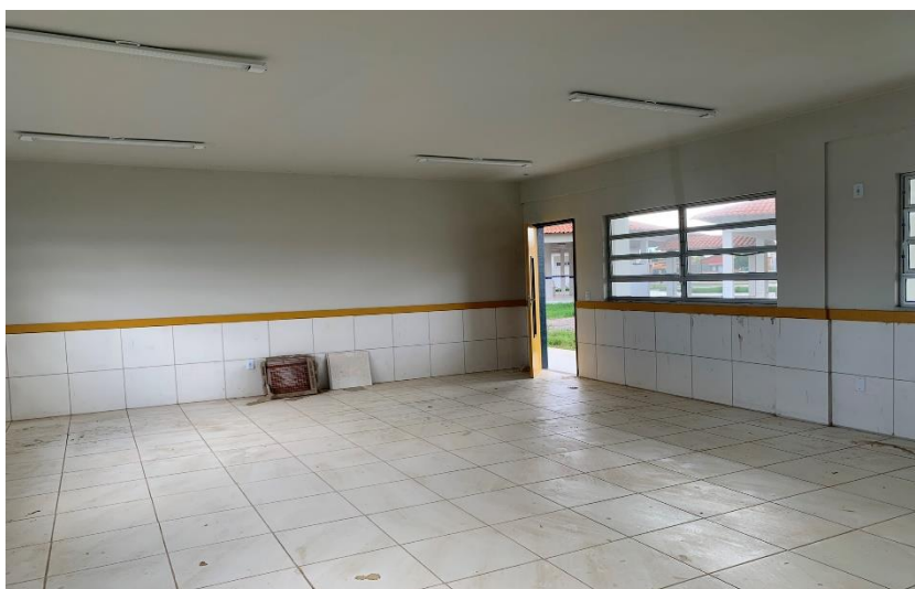
Figura 18 - Detalhe Sala de Aula do Bloco Pedagógico.
