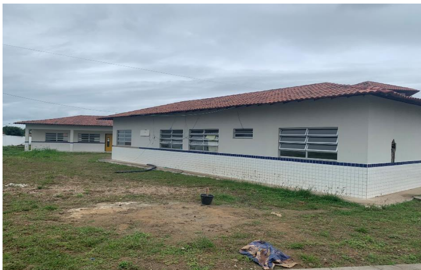
Figura 8 - Vista 02 fachada do Bloco Administrativo.
