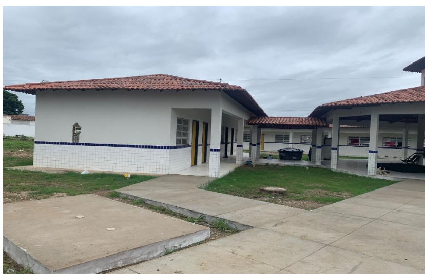
Figura 7 - Vista 01 fachada do Bloco Administrativo.
