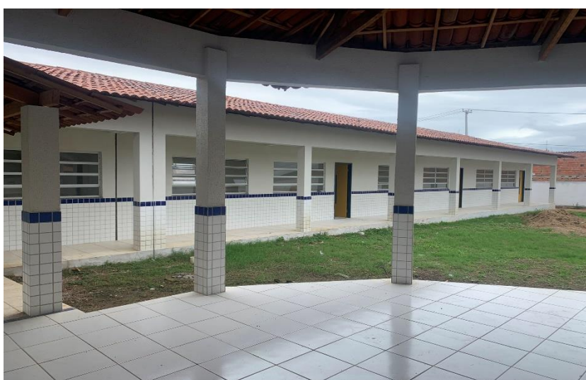
Figura 6 - Vista fachada frontal lateral direita do Bloco Pedagógico.
