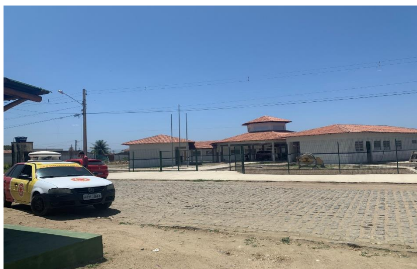
Figura 27 - Vista fachada frontal direita.
