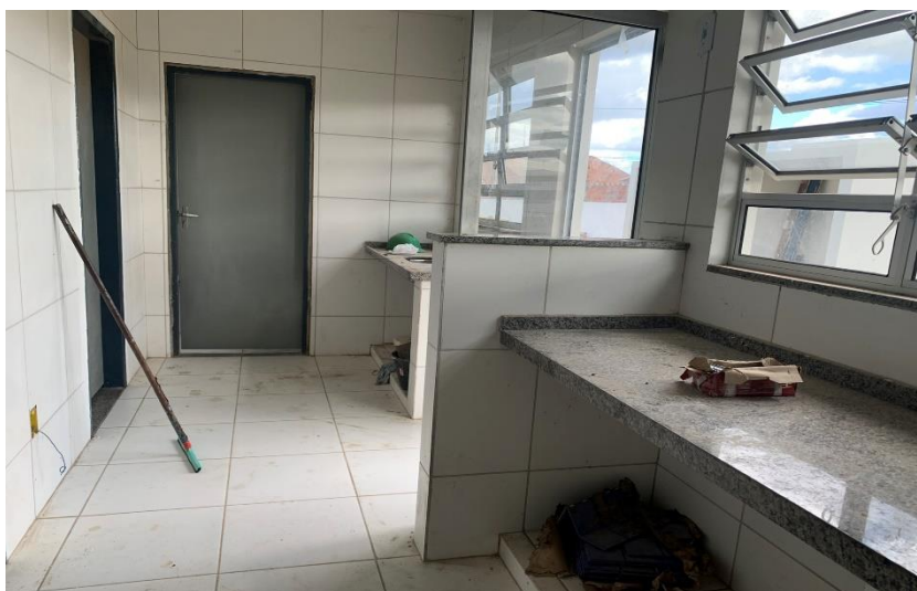
Figura 17 - Detalhe da Área de Serviço – Bloco de Serviço.
