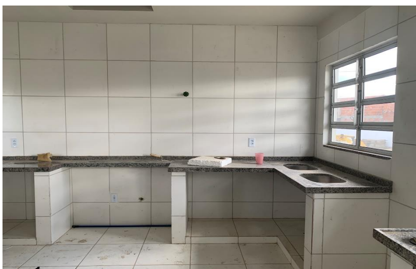
Figura 16 – Detalhe da Cozinha – Bloco de Serviço.
