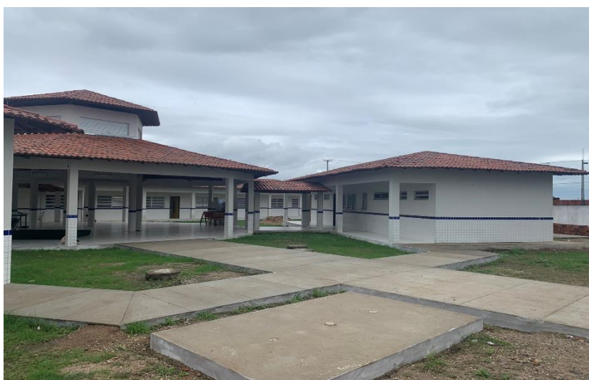
Figura 9 - Vista do Bloco de Serviços.
