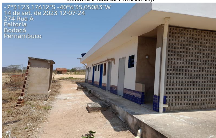
Figura 6 - Vista fachada lateral esquerda (Triagem e Lavagem, Lavanderia, Vestiários Feminino e Masculino, S.T.I, S.E.E, Casa de Lixo e Gás).
