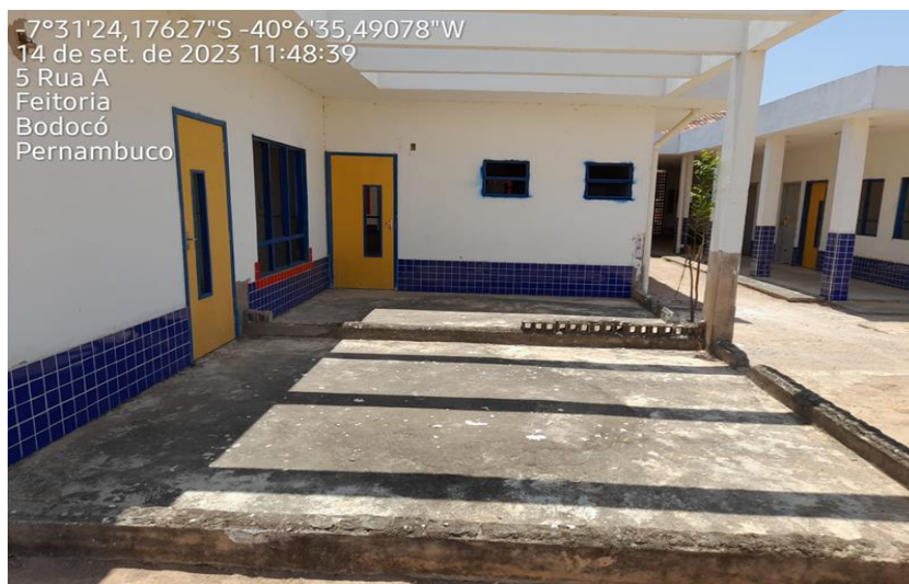
Figura 27 - Vista do Bloco Creches I e II (Creche I, Repouso e Solarium).
