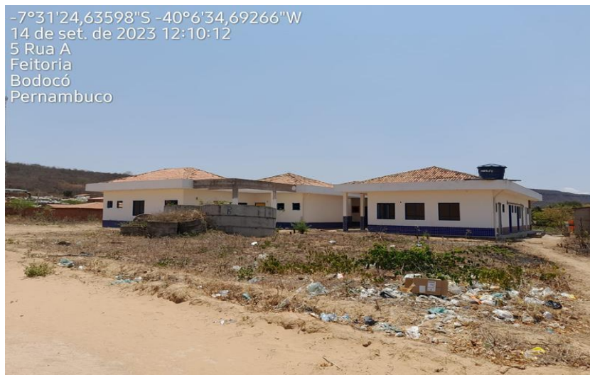
Figura 7 - Vista fachada fundos lateral direita (Multiuso e Informática).
