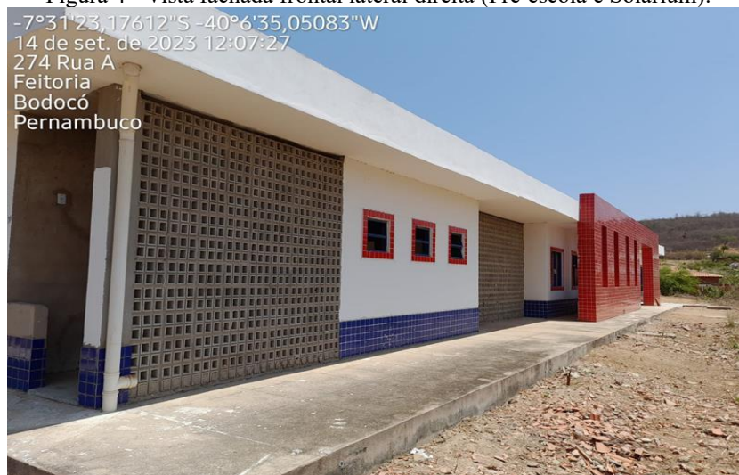
Figura 5 - Vista fachada frontal lateral esquerda (Triagem e Lavagem, Cozinha e Sala de Professores).
