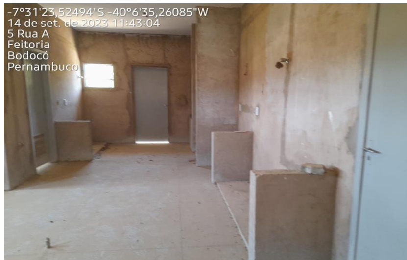
Figura 19 - Vista do Bloco de Serviço (Cozinha).
