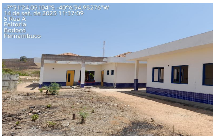
Figura 26 - Vista do Bloco Creches I e II (Creche I, Repouso e Solarium).
