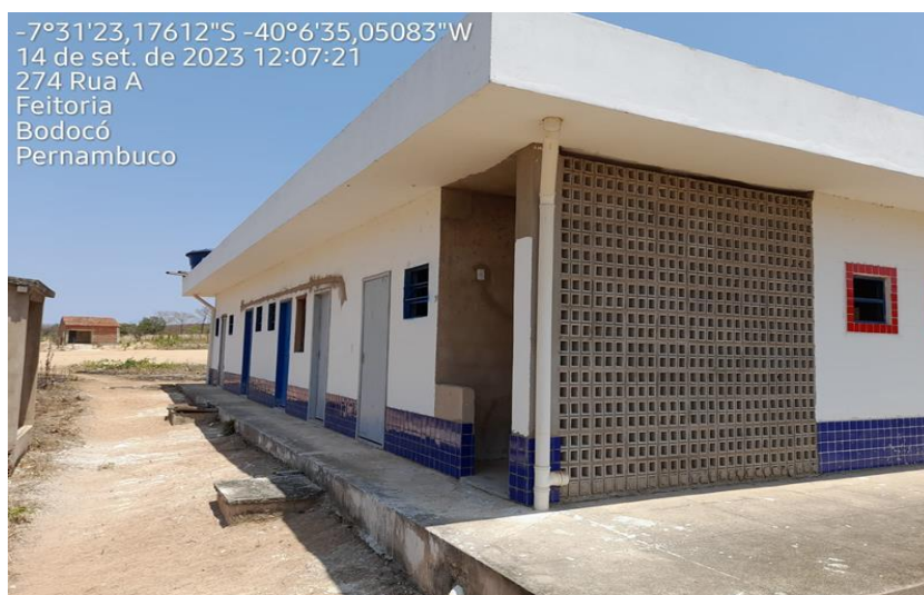
Figura 17 - Vista do Bloco de Serviço.
