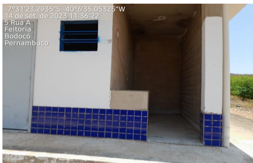
Figura 21 - Vista do Bloco de Serviço (Triagem e Lavagem).
