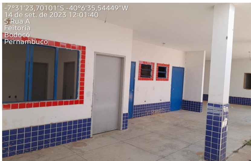
Figura 12- Vista do Bloco administrativo.
