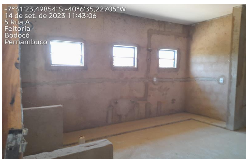
Figura 20 - Vista do Bloco de Serviço (Cozinha).
