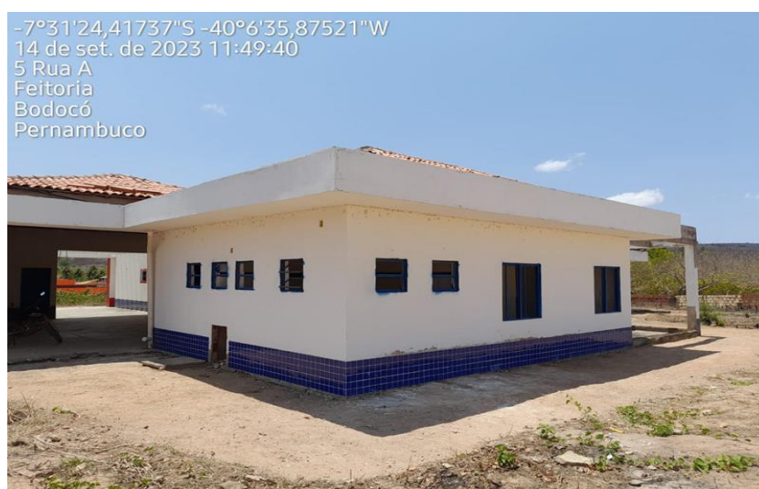
Figura 25 - Vista do Bloco Creches I e II (Fraldário, Repouso).
