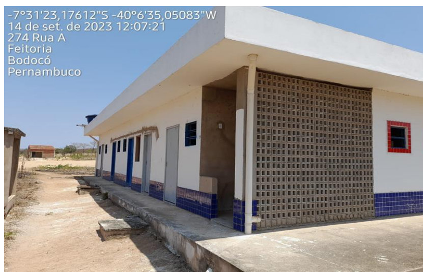
Figura 23 - Vista do Bloco de Serviço.
