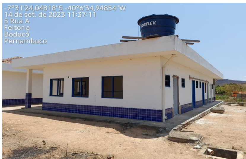
Figura 18 - Vista do Bloco de Serviço..
