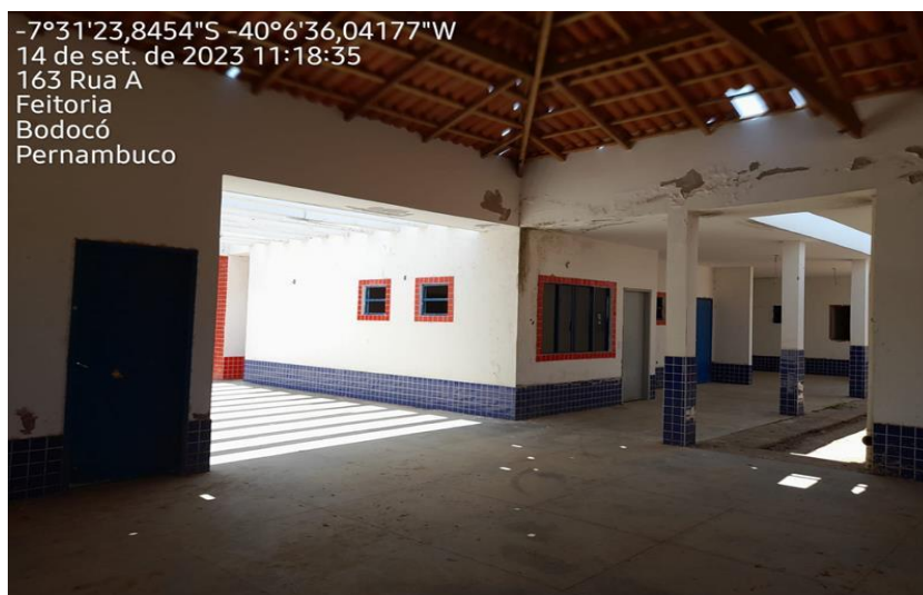
Figura 11- Vista do Bloco administrativo.
