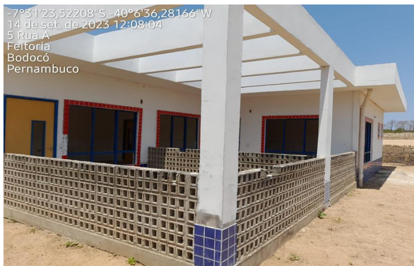
Figura 10 - Vista fachada lateral direita (Pré-escola, Solarium e Creche III).
