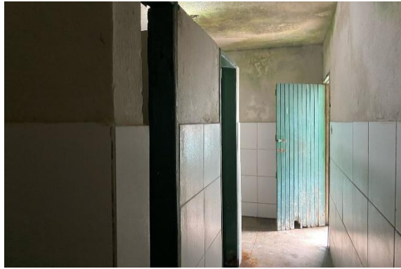
FOTO 13: ÁREA INTERNA - BANHEIRO
