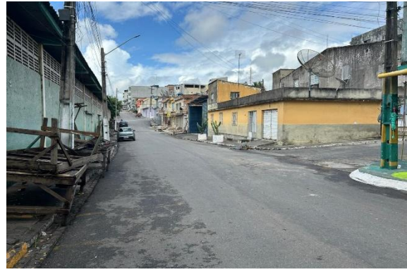
FOTO 2: FACHADA LATERAL DIREITA
