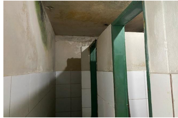
FOTO 14: ÁREA INTERNA - BANHEIRO
