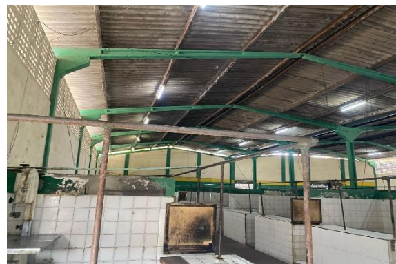
FOTO 12: ÁREA INTERNA - COBERTA
