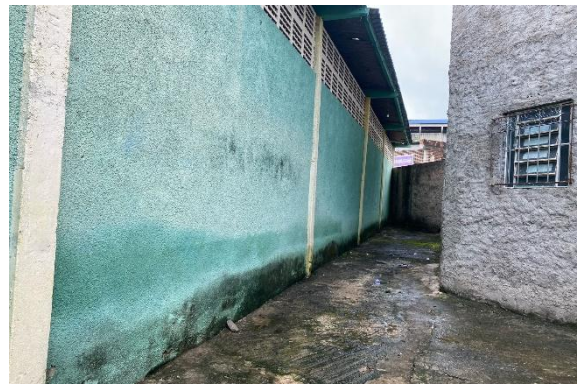
FOTO 4: FACHADA LATERAL ESQUERDA
