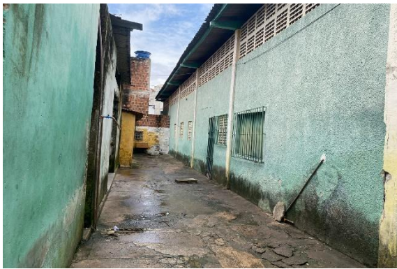
FOTO 3: FACHADA LATERAL ESQUERDA
