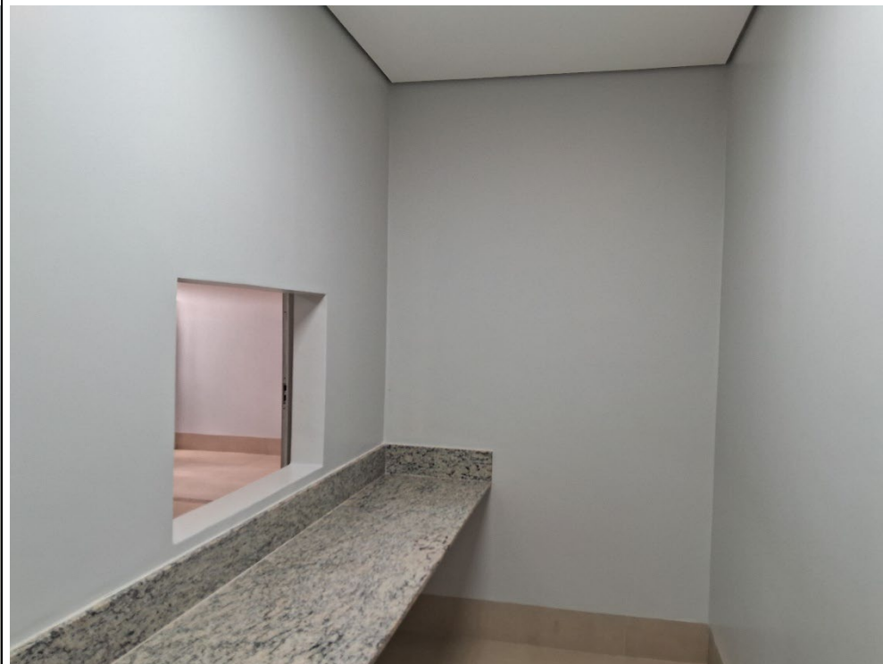
Foto 10 – Vista geral da sala de comando.
