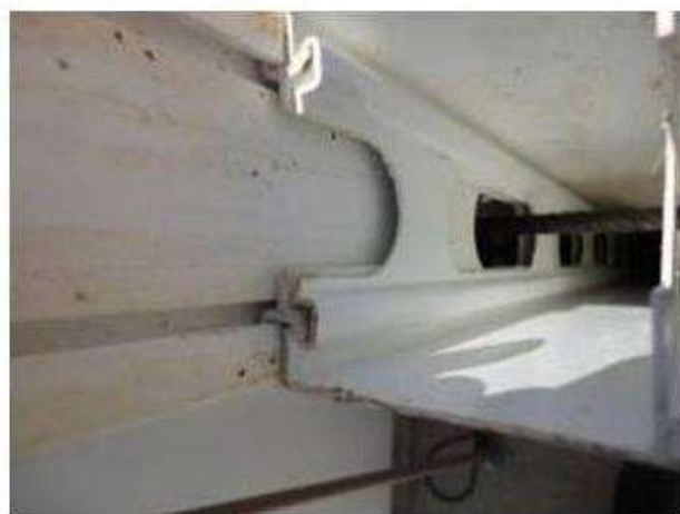
Imagem 05 - Ferragem posicionada na região da contra-verga
