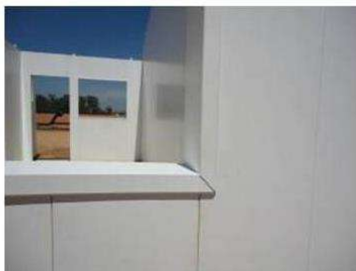
Imagem 08 - Abertura das janelas com acabamentos em PVC
