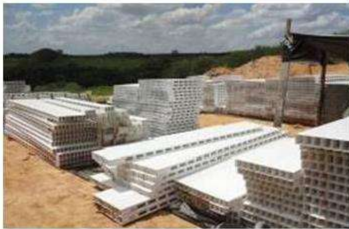
Imagem 03 - Painéis de PVC pré-moldados na fábrica
