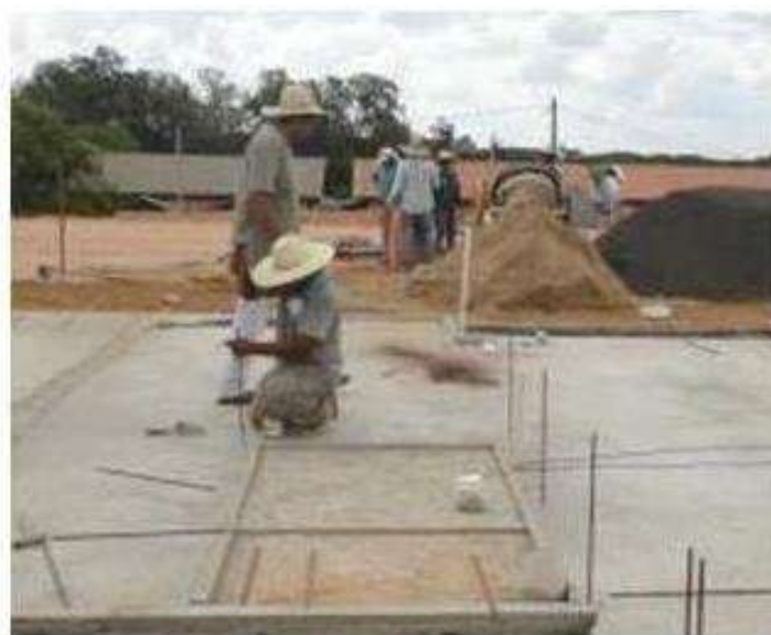
Imagem 02 - Fixação das barras de ancoragem à fundação com adesivo epóxi
