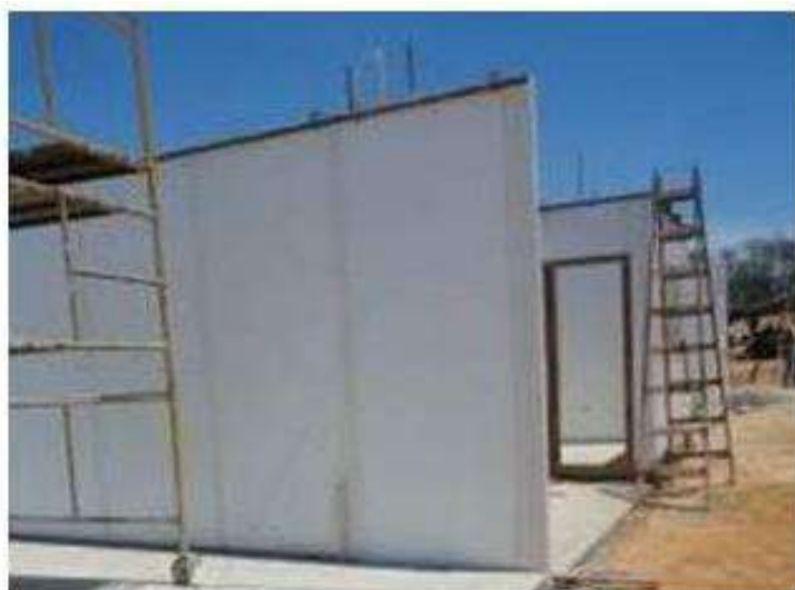
Imagem 04 - Painéis de PVC posicionados e escorados
