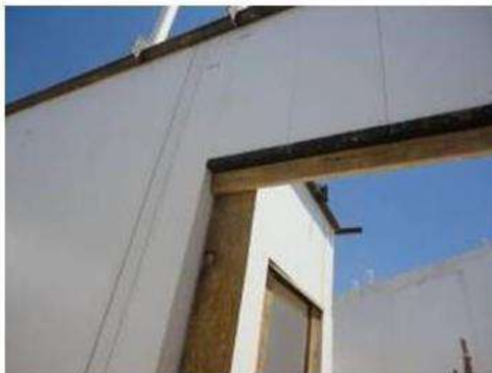
Imagem 07 - Painéis de PVC concretados
