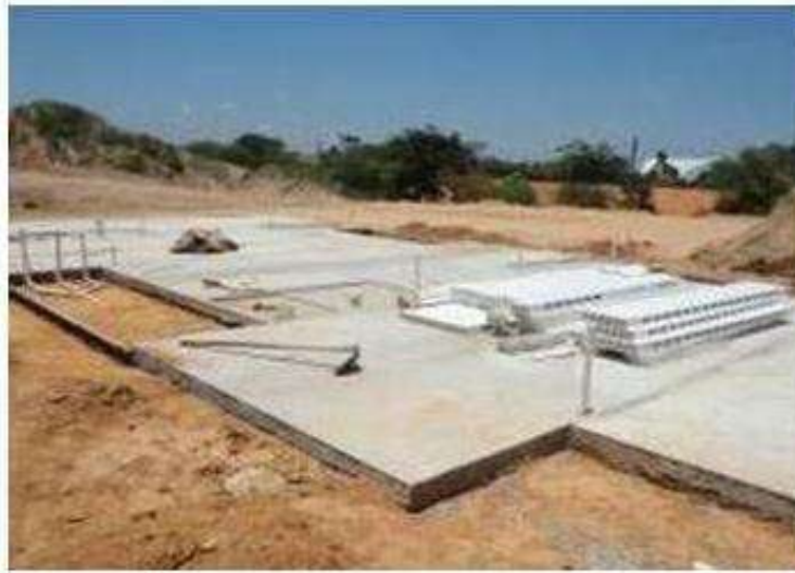
Imagem 01 - Elemento de fundação com planicidade adequada
