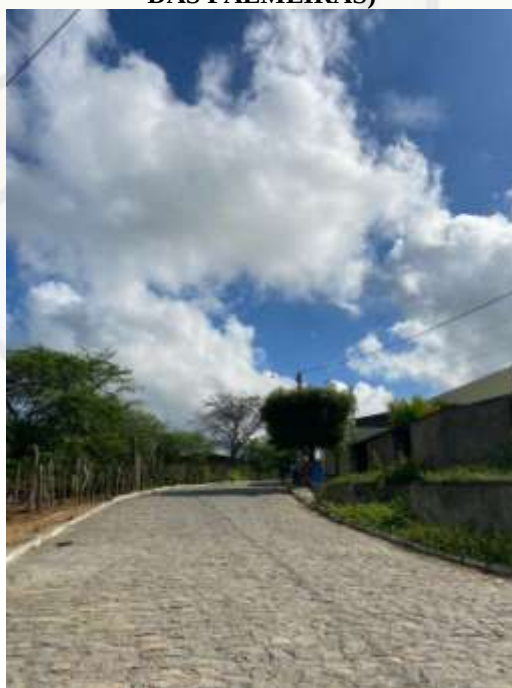
Figura 5. RECAPEAMENTO ASFÁLTICO EM DIVERSAS NO MUNICÍPIO DE IBIRAJUBA (RUA DAS PALMEIRAS)
