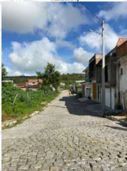
Figura 1. RECAPEAMENTO ASFÁLTICO EM DIVERSAS NO MUNICÍPIO DE IBIRAJUBA (RUA ALZIRA)
