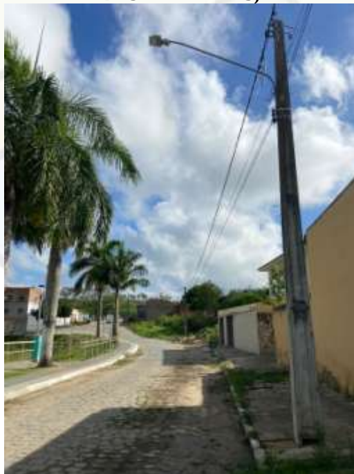
Figura 9. RECAPEAMENTO ASFÁLTICO EM DIVERSAS NO MUNICÍPIO DE IBIRAJUBA (RUA DAS PALMEIRAS)
