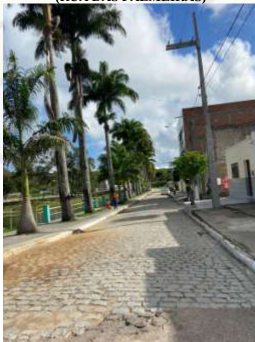
Figura 13. RECAPEAMENTO ASFÁLTICO EM DIVERSAS NO MUNICÍPIO DE IBIRAJUBA (RUA DAS PALMEIRAS)
