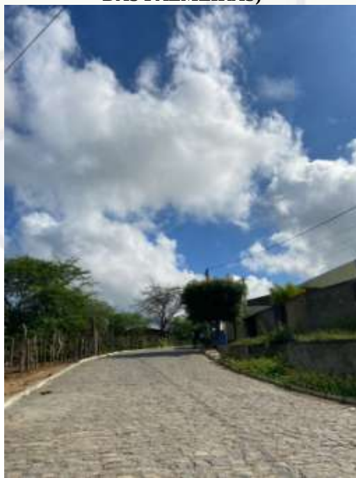
Figura 7. RECAPEAMENTO ASFÁLTICO EM DIVERSAS NO MUNICÍPIO DE IBIRAJUBA (RUA DAS PALMEIRAS)
