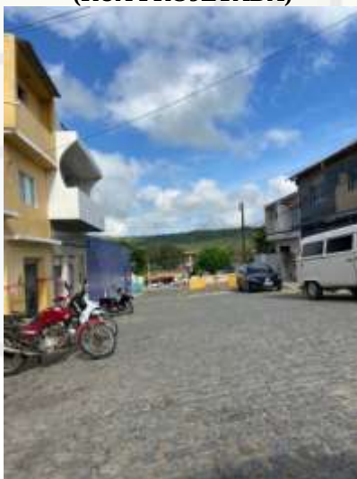
Figura 15. RECAPEAMENTO ASFÁLTICO EM DIVERSAS NO MUNICÍPIO DE IBIRAJUBA (RUA PROJETADA)
