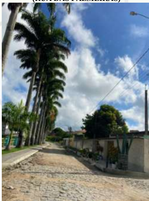
Figura 11. RECAPEAMENTO ASFÁLTICO EM DIVERSAS NO MUNICÍPIO DE IBIRAJUBA (RUA DAS PALMEIRAS)
