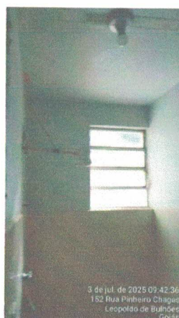
Foto: Sanitário Quarto 01.
