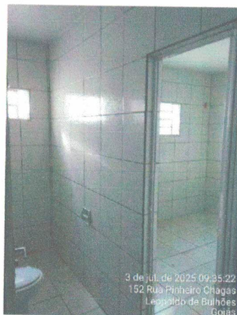
Foto: Sanitário de Funcionários.
