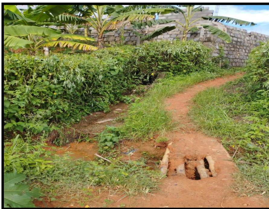
Imagem 3- Trecho Rua das Fábricas
