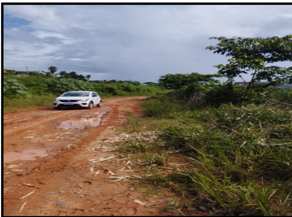
Imagem 6- Trecho Rua das Fábricas
