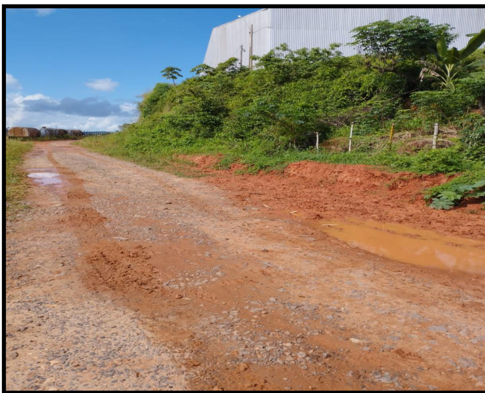
Imagem 5- Trecho Rua das Fábricas
