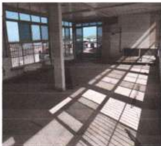
Fig. 07 - Vista interna Cobertura.
