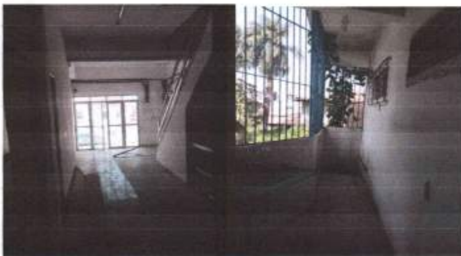
Fig. 05 – Vista interna 1º andar.
