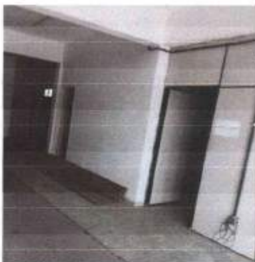
Fig. 03 – Vista interna 1º andar.
