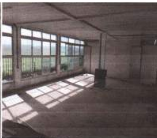
Fig. 08 - Vista interna cobertura.
