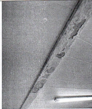
Manutenção da coberta
