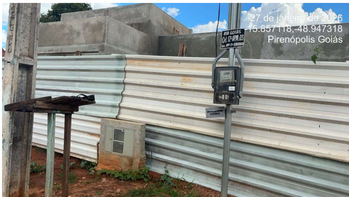
Figura 04: Local da construção da nova Unidade Básica de Saúde
