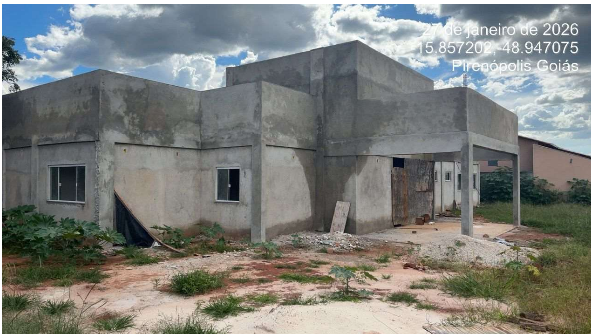
Figura 02: Local da construção da nova Unidade Básica de Saúde
