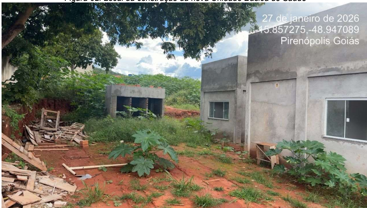
Figura 03: Local da construção da nova Unidade Básica de Saúde
