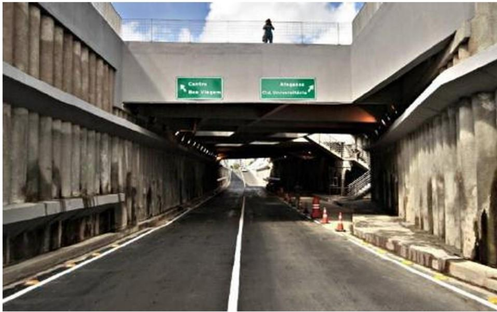
Figura 3 – Túnel da Abolição sentido Av. Abdias de Carvalho
