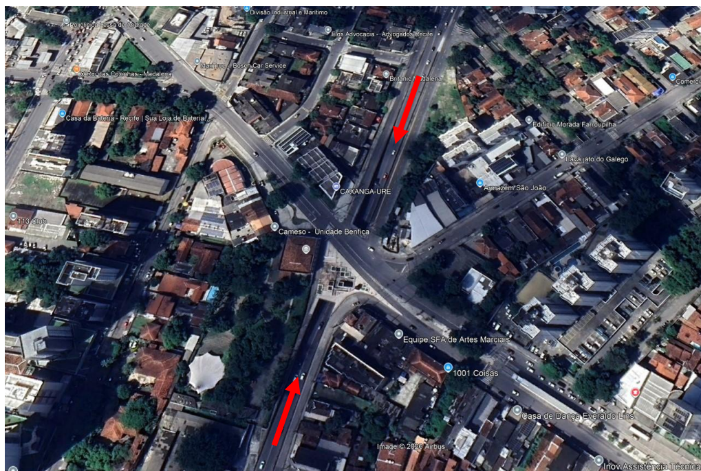
Figura 1 – Túnel da Abolição visto de cima.
