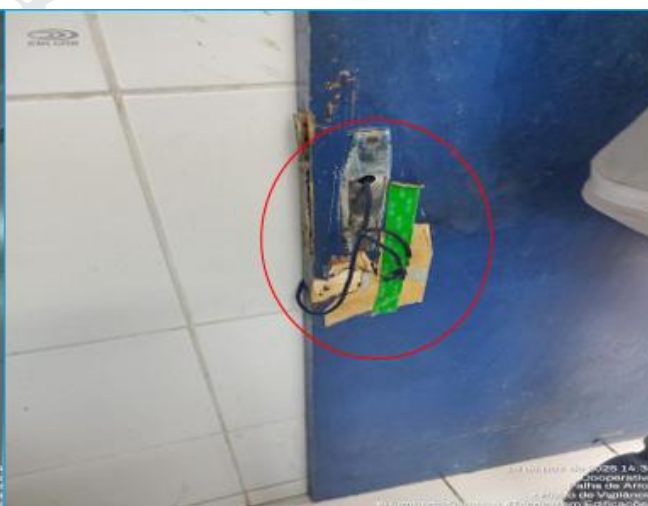
Foto 02: Fechadura quebrada 01.
