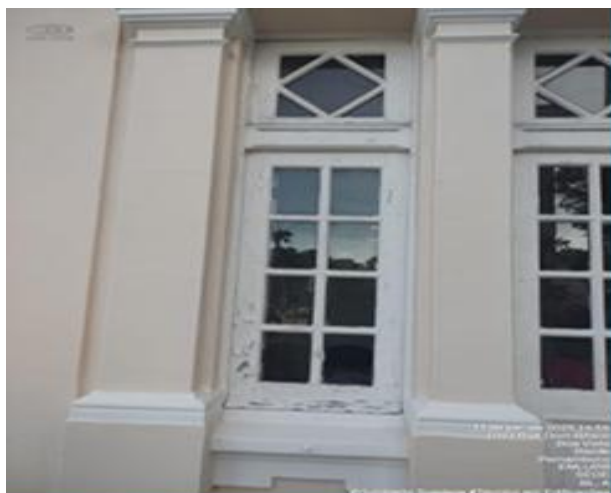
Foto 65: BL A, pintura das janelas venezianas para conservação.
