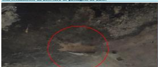
Foto 19: BL B, elemento de mangueira do ar-condicionado foi instalado sem fechamento da abertura de passagem do duto.
