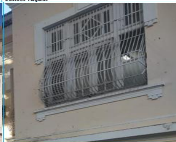
Foto 70: BL A, pintura das janelas venezianas para conservação.
