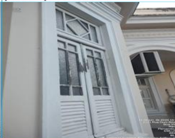
Foto 64: BL A, pintura das janelas venezianas para conservação.
