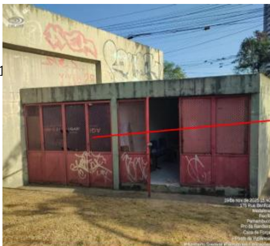
Foto 01: Posto dentro do banheiro público.
