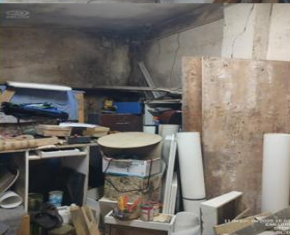
Foto 24: BL D, Marcenaria, presença de mofo e bolor devido à infiltração nos telhados.
