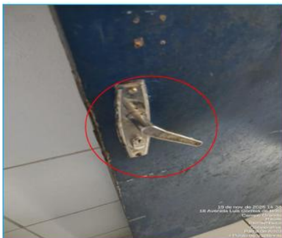
Foto 03: Fechadura quebrada 02.
