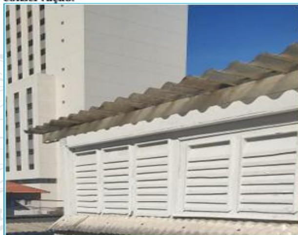
Foto 69: BL A, pintura das janelas venezianas da cúpula para conservação.
