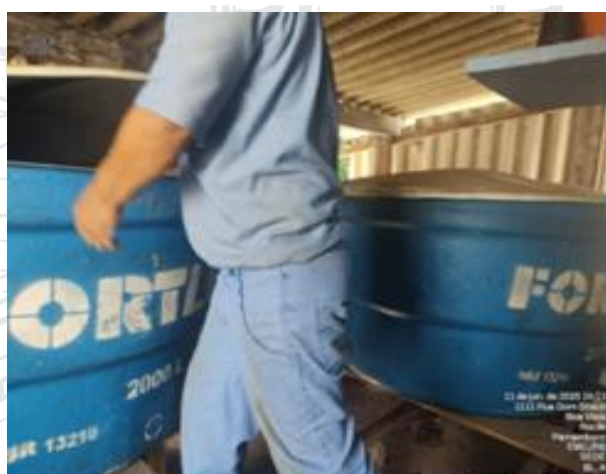
Foto 37: BL A, dois reservatórios superiores de 2000L cada, precisando de limpeza.
