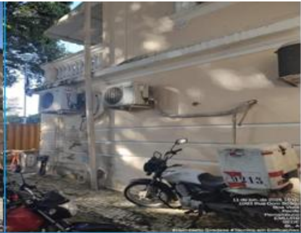
Foto 46: BL A, precisando de limpeza e pintura.
