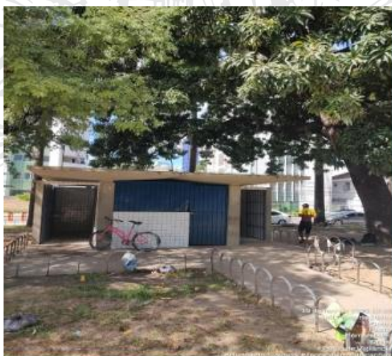
Foto 01: Posto dentro do banheiro público.
