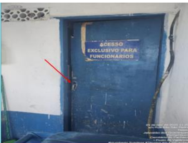
Foto 08: Fechadura quebrada.
