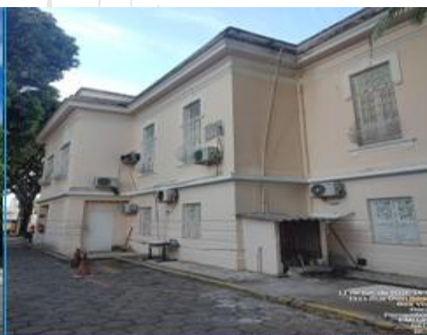
Foto 44: BL A, precisando de limpeza e pintura.
