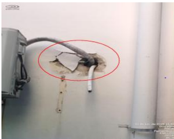
Foto 19: BL B, elemento de mangueira do ar-condicionado foi instalado sem fechamento da abertura de passagem do duto.
