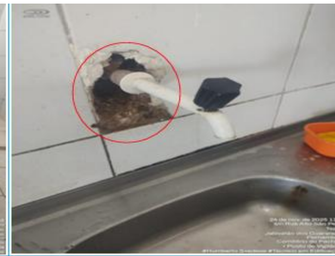
Foto 04: Interruptor sem capa.
