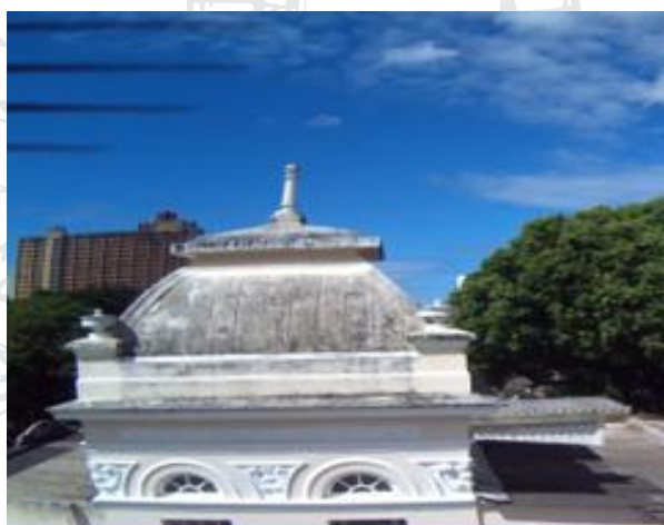
Foto 43: BL A, cúpula precisando de limpeza e pintura para proteção.
