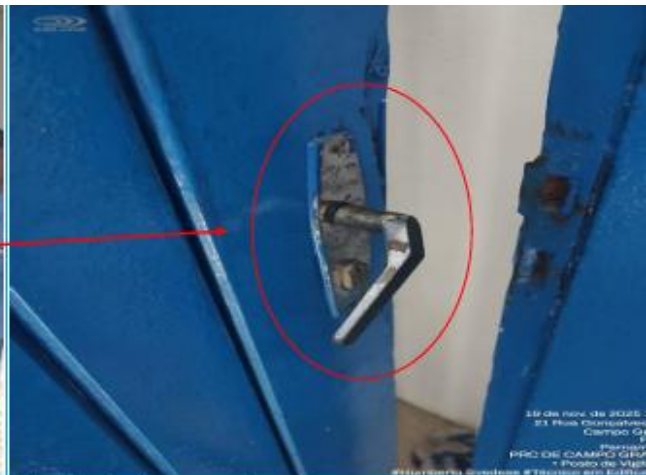
Foto 04: Fechadura quebrada.
