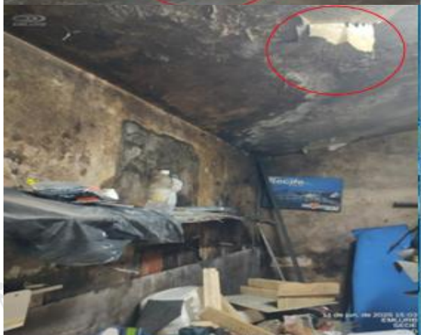
Foto 23: BL D, Marcenaria, presença de mofo e bolor devido à infiltração nos telhados.
