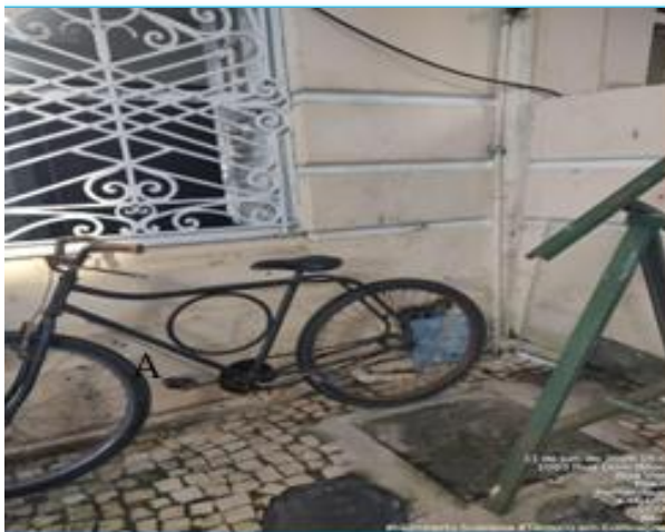
Foto 47: BL A, precisando de limpeza e pintura.
