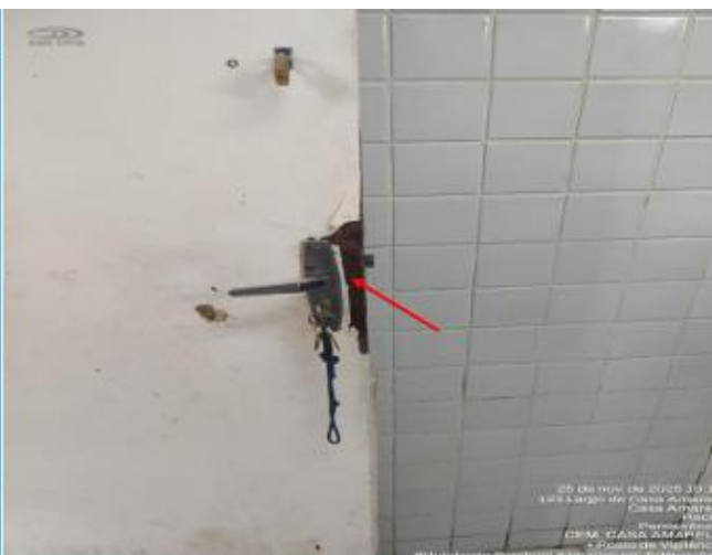
Foto 02: Fechadura quebrada.
