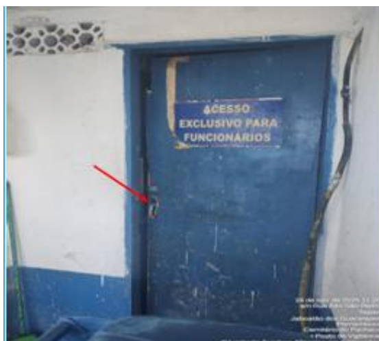
Foto 05: Fechadura quebrada.
