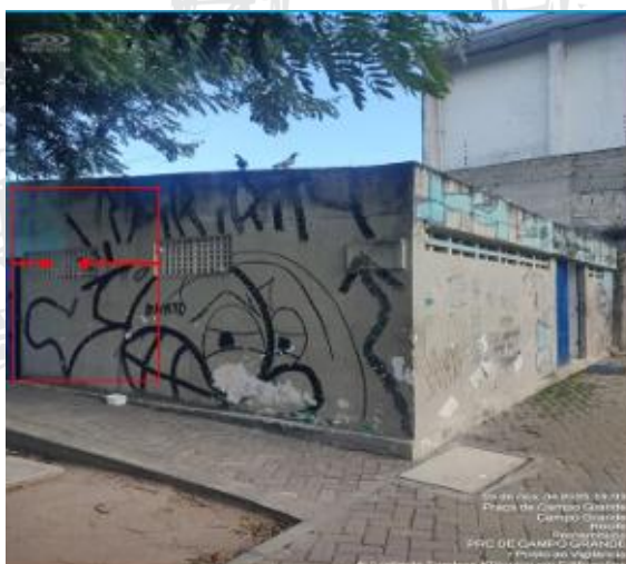
Foto 01: Posto dentro do banheiro público.
