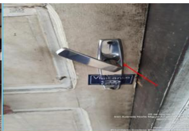
Foto 02: Fechadura quebrada.
