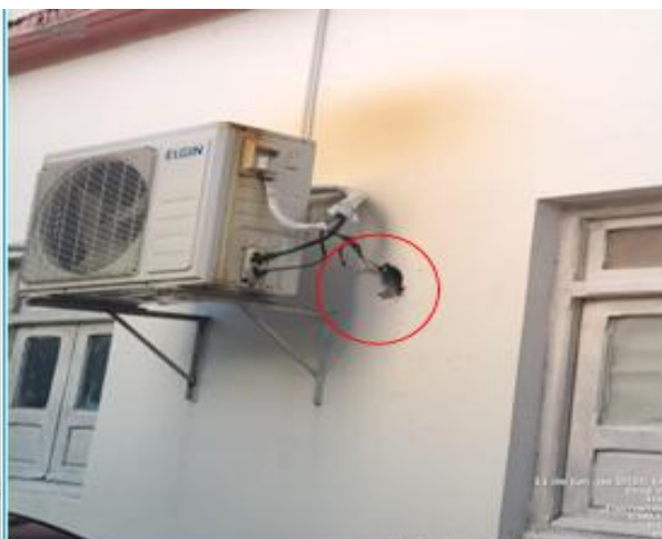
Foto 20: BL B, elemento de mangueira do ar-condicionado foi instalado sem fechamento da abertura de passagem do duto.
