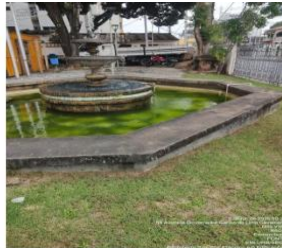
Foto 04: pedestal central com sujeira
