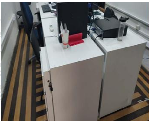
Foto 29: Piso precisando ser envernizado.
