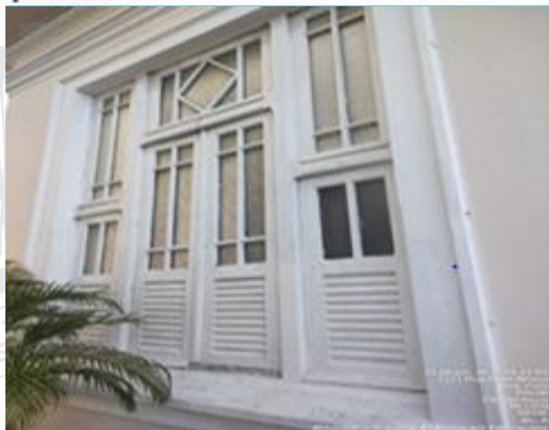
Foto 63: BL A, pintura das janelas venezianas para conservação.
