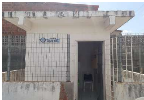
Foto 02 - Casa de Proteção
