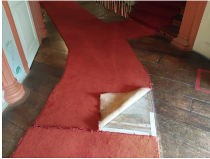
Imagem 02 e 03: Tapeçaria dos corredores descolando, desgastados e desbotados.
