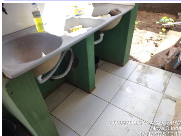
Foto 23: Substituir tanque de lavar.
