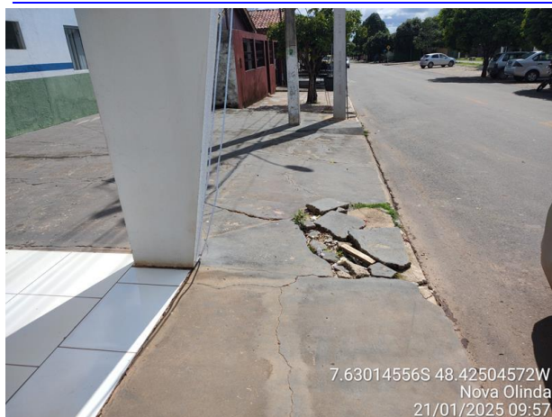
Foto 07: Calçadas externa recuperação de contrapiso.
