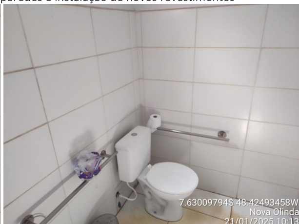
Foto 33 e 34: WC PNE remoção de revestimento de paredes e instalação de novos revestimentos
