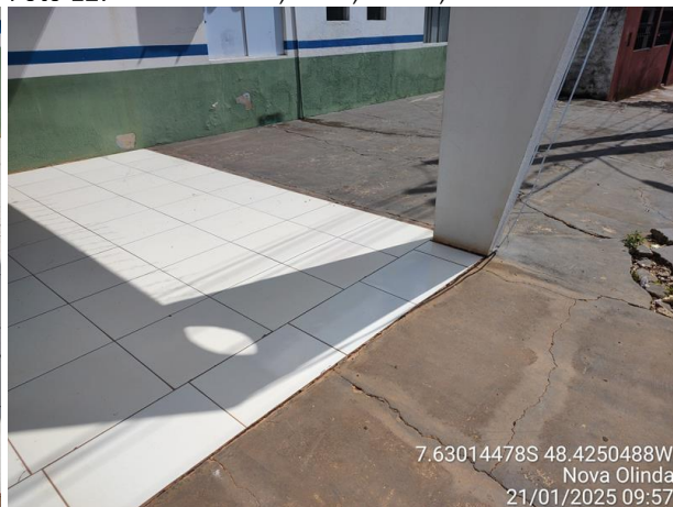
Foto 14: Entrada, retirar piso cerâmico e assentar novo.
