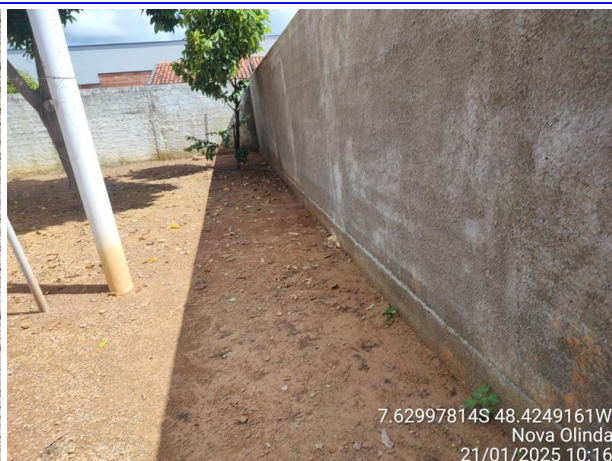
Foto 16: Fazer reboco interno de muro.
