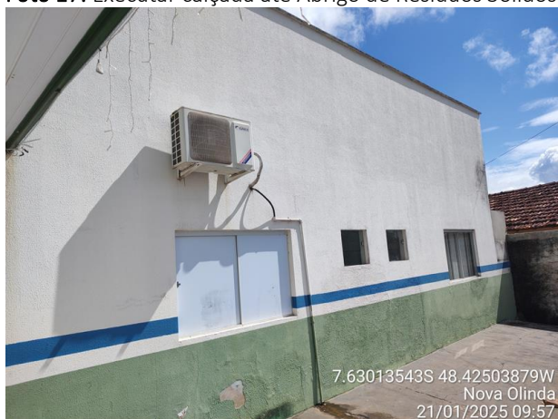
Foto 19: Embutir tubulação de ar condicionado.
