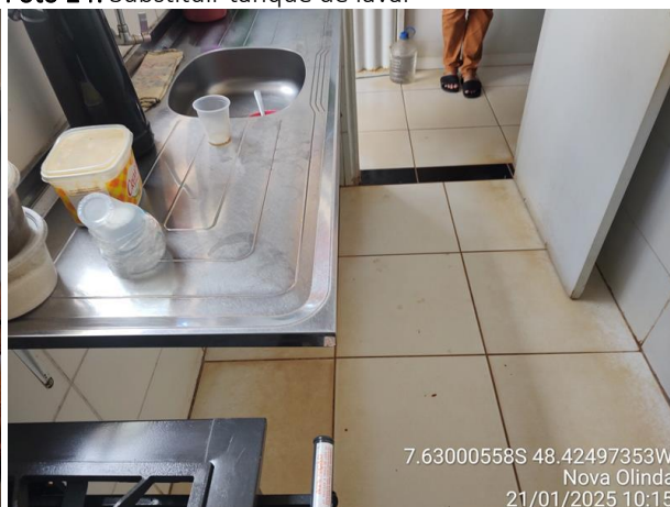
Foto 26: remoção e instalação de nova pia da copa.
