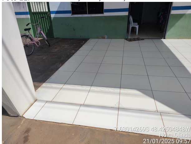
Foto 13: Entrada, retirar piso cerâmico e assentar novo.
