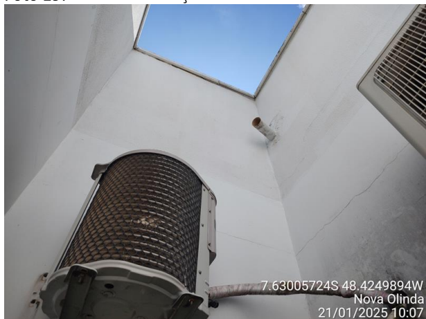
Foto 21: Embutir tubulação de ar condicionado.
