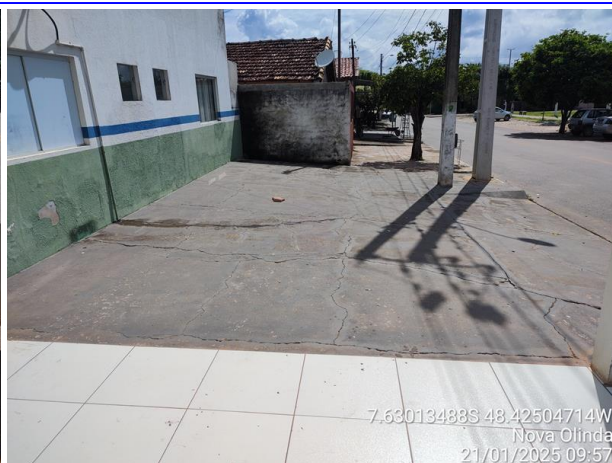
Foto 08: Calçadas externa a pintar com tinta piso.
