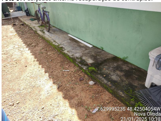
Foto 09: Calçadas externa a pintar com tinta piso.
