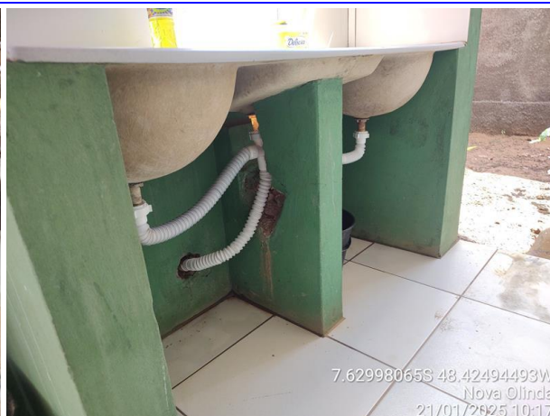
Foto 24: Substituir tanque de lavar
