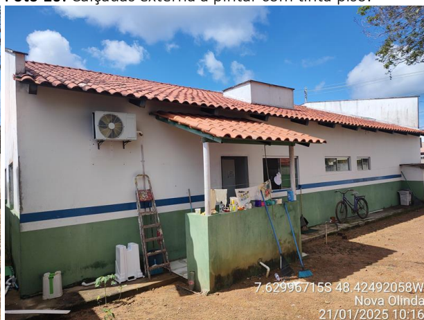
Foto 12: Substit. telhas, forro, calhas, rufos da cobertura.
