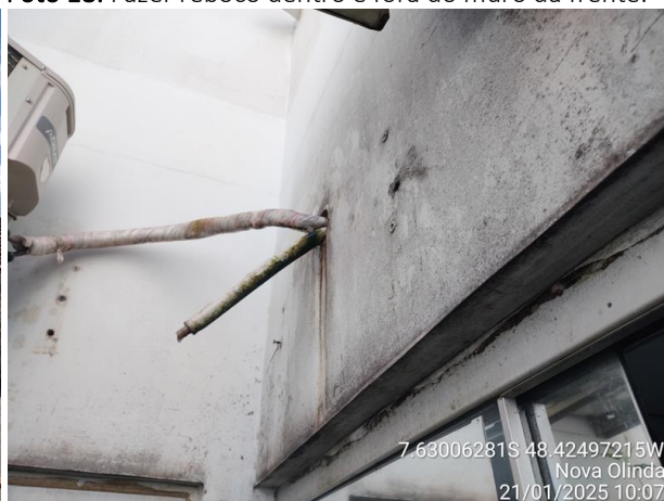
Foto 20: Embutir tubulação de ar condicionado.
