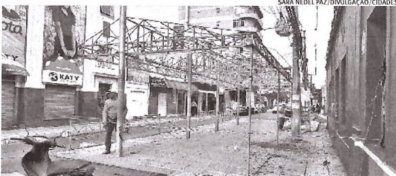
Estrutura que ficava na rua João Neves da Fontoura foi desmontada
