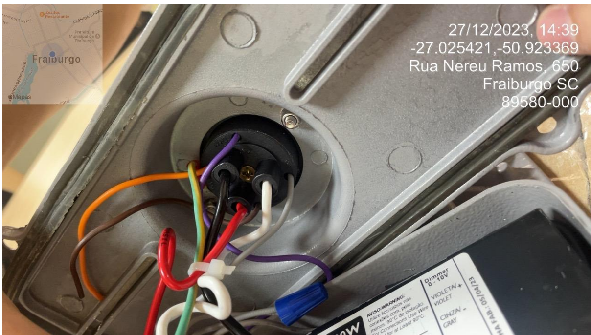
Figura 23 - Fixação da tomada de relé, com parafusos adequados
