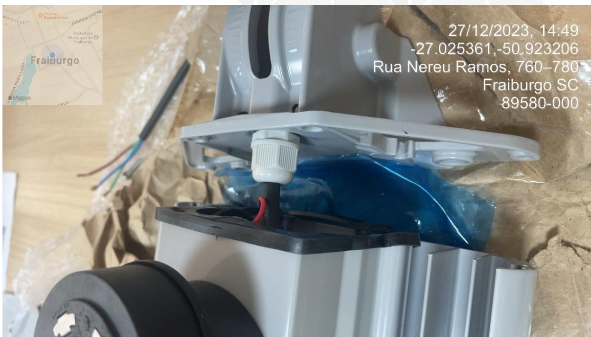
Figura 14 - Ancoragem do cabo externo do item 7
