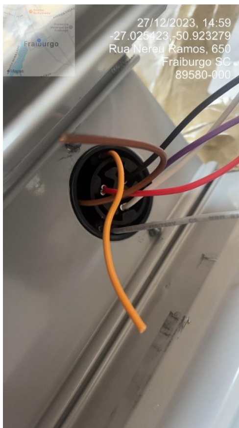
Figura 17 - Fixação da tomada do relé, com parafusos adequados e com as pontas protegidas
