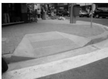
Nos rebaixamentos de calçadas, em cor contrastante com a do piso, com largura de 0,25 a 0,50m, afastada 0,50m do término da rampa.
