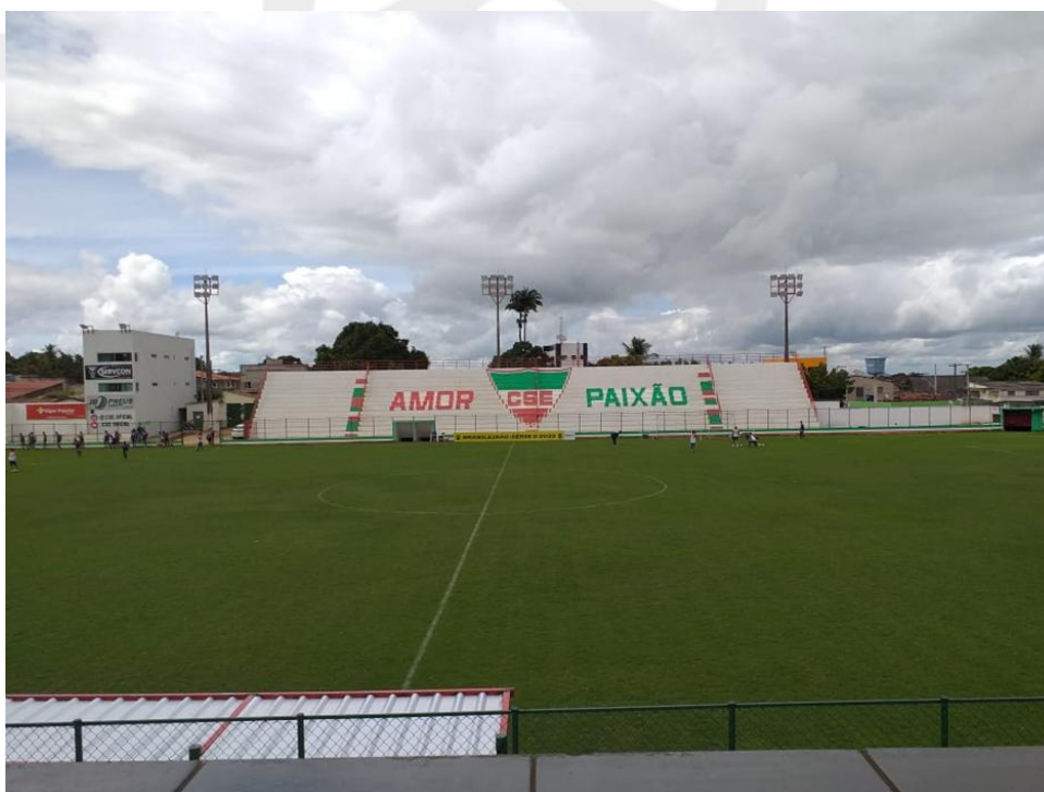
Foto 7: Vista frontal dos dois túneis que serão reformados;
