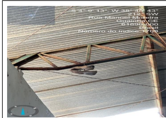
FOTO Nº REFORMA DO GINÁSIO DURVAL CAVALCANTE EM ÁGUA VERDE - GUAÍÚBA/CE 2 OUTUBRO 2025
