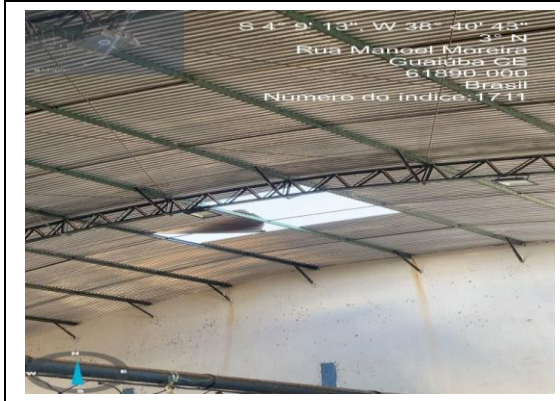
FOTO Nº REFORMA DO GINÁSIO DURVAL CAVALCANTE EM ÁGUA VERDE - GUAÍÚBA/CE 5 OUTUBRO 2025
