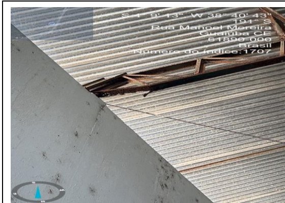
FOTO Nº REFORMA DO GINÁSIO DURVAL CAVALCANTE EM ÁGUA VERDE - GUAÍÚBA/CE 1 OUTUBRO 2025
