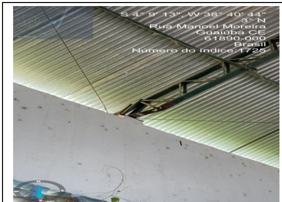
FOTO Nº REFORMA DO GINÁSIO DURVAL CAVALCANTE EM ÁGUA VERDE - GUAÍÚBA/CE 3 OUTUBRO 2025
