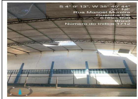
FOTO Nº REFORMA DO GINÁSIO DURVAL CAVALCANTE EM ÁGUA VERDE - GUAÍÚBA/CE 6 OUTUBRO 2025
