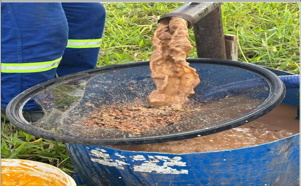
SP-03 – Circulação de água do furo de Sondagem
