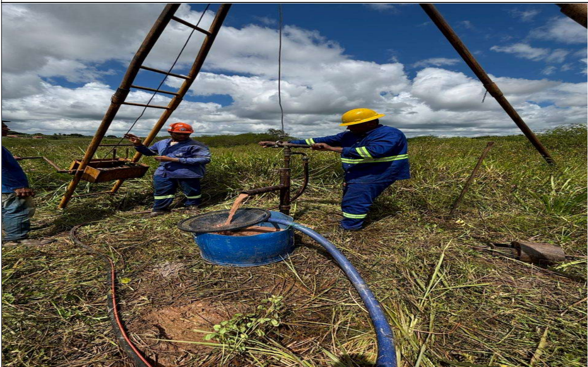
SP-01 – Circulação de água do furo de Sondagem
