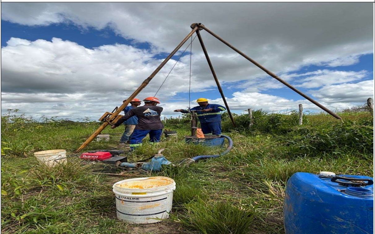
SP-06 – Circulação de água do furo de Sondagem
