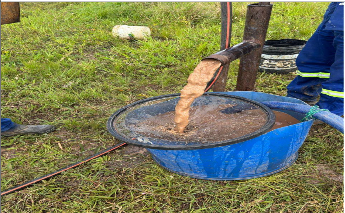
SP-02 – Circulação de água do furo de Sondagem
