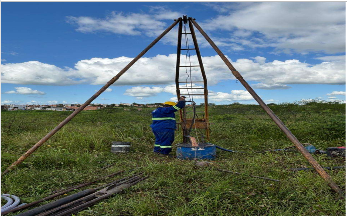
SP-04 – Circulação de água do furo de Sondagem
