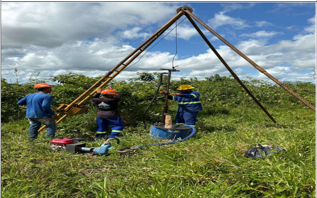
SP-05 – Circulação de água do furo de Sondagem
