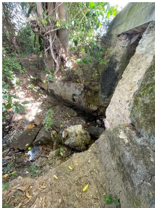
FOTO 09 - Vista lateral da base da ponte e do leito do riacho, onde se observa a presença de bloco de pedras soltas e possíveis processos erosivos junto às fundações.
