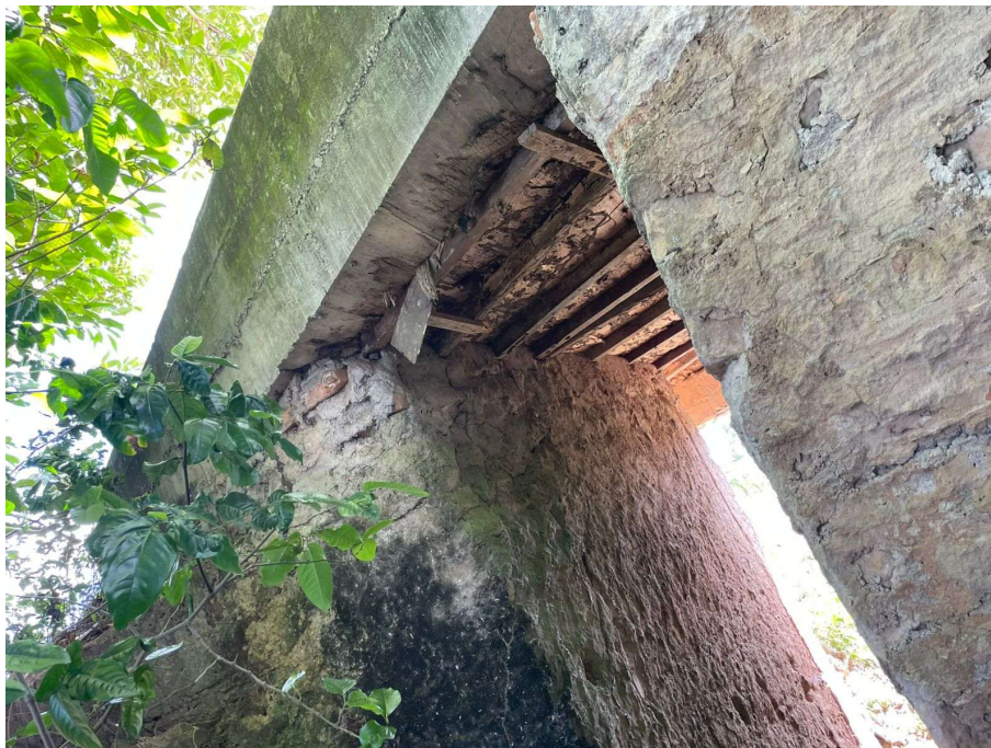
FOTO 04 - Vista inferior da ponte mostrando elementos estruturais deteriorados e exposição das vigas ou apoios inferiores , indicando comprometimento da integridade estrutural.
