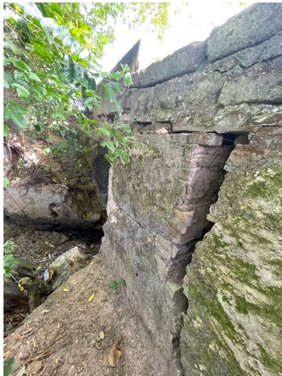
FOTO 10 - Detalhe da parede estrutural lateral apresentando fissura vertical significativa , indicando possível deslocamento da alvenaria estrutural.
