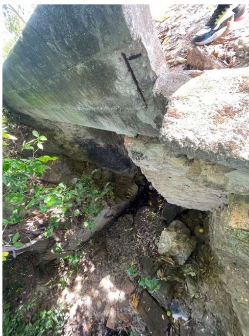
FOTO 13 - Detalhe da região inferior da ponte evidenciando contato direto entre elementos estruturais e blocos rochosos, com sinais de erosão e deslocamento de material.
