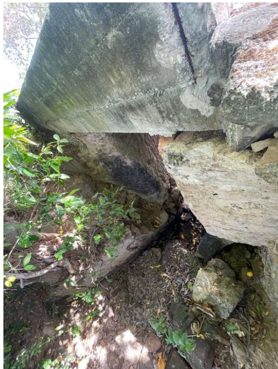
FOTO 12 - Detalhe inferior da estrutura da ponte, com evidência de deslocamento entre elementos estruturais e possível comprometimento do apoio.
