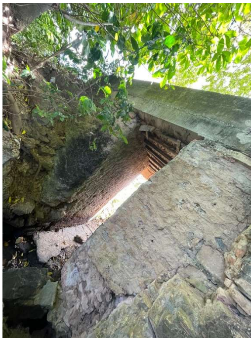
FOTO 07 - Vista inferior do encontro da ponte com presença de fissuras e desgaste das pedras estruturais, demonstrando perda de material e fragilidade da estrutura.
