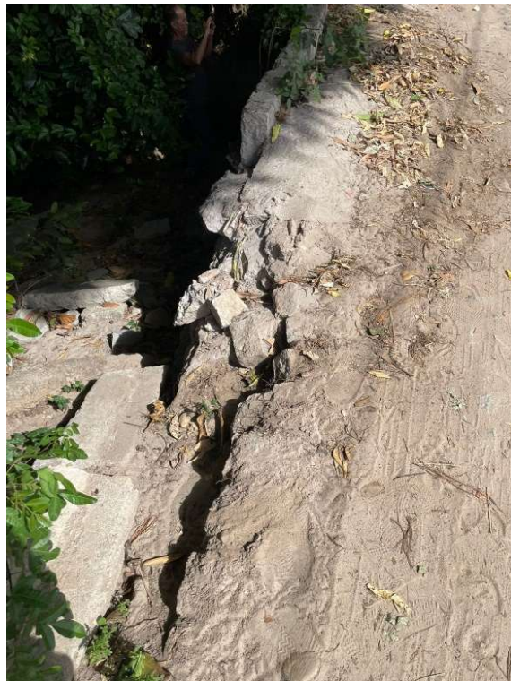
FOTO 14 - Vista da borda da ponte e da pista de terra apresentando abatimento do bordo da plataforma , indicando instabilidade e possível risco ao tráfego.
