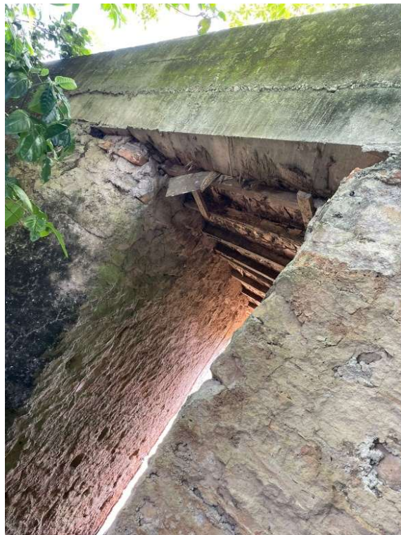
FOTO 06 - Detalhe da parte inferior da ponte com evidência de desagregação da alvenaria e deterioração dos elementos estruturais , com risco de agravamento das patologias.
