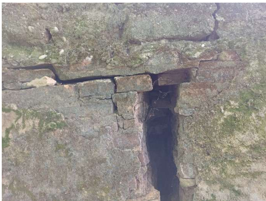
FOTO 15 - Detalhe de fissura estrutural significativa na alvenaria de pedra e tijolos, demonstrando deslocamento entre blocos e comprometimento da integridade da parede estrutural.
