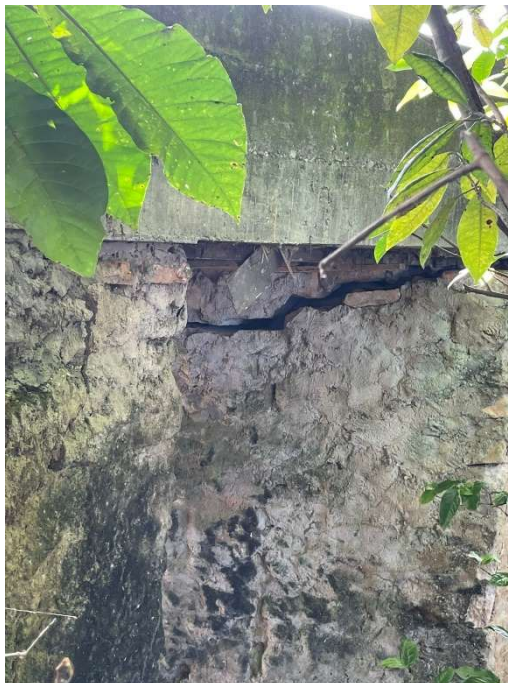
FOTA 02 - Detalhe da parede lateral em alvenaria de pedra da ponte, apresentando fissura significativa na parte superior , indicando possível movimentação estrutural ou recalque da fundação.
