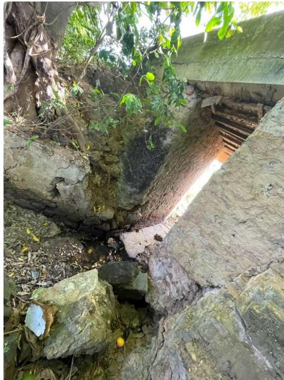
FOTO 08 - Detalhe do encontro estrutural sobre o riacho, com presença de blocos deslocados e sinais de erosão na base da estrutura.
