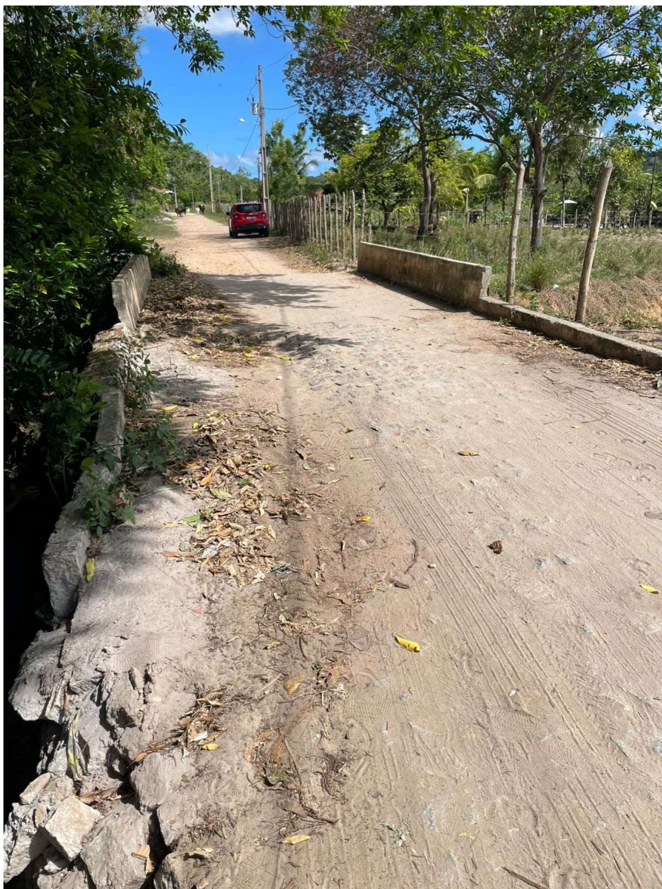
FOTO 01 - Vista geral da estrada vicinal e do acesso à ponte existente, observando-se a plataforma de terra e os elementos laterais da estrutura da ponte. Nota-se desgaste nas bordas da pista e início de deterioração nos elementos de contenção laterais.
