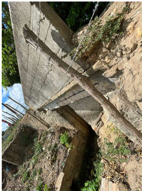
FOTO 03 - Vista lateral inferior da ponte, evidenciando a estrutura de apoio e o canal do riacho. Observa-se deterioração do encontro da ponte e exposição de partes estruturais.
