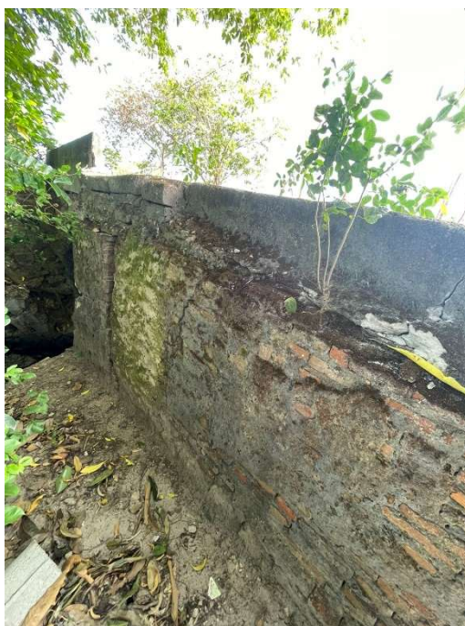
FOTO 11 - Vista da parte superior da parede lateral da ponte, com presença de vegetação e desgaste da alvenaria, evidenciando a degradação progressiva.
