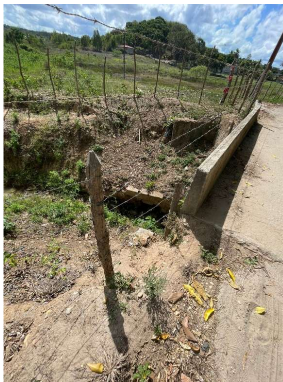
FOTO 05 - Vista lateral da ponte e do talude adjacente, evidenciando o sistema de drenagem natural do riacho e a proximidade da estrutura com a área de escoamento.
