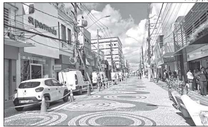
ENERGISA segue intensificando as ações para remoção de cabos irregulares e clandestinos no Centro de Aracaju
