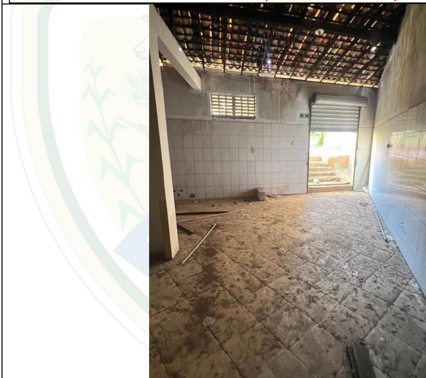
ÁREA DOS FUNDOS DO IMÓVEL, RUA PRINCESA ISABEL, Nº 24
