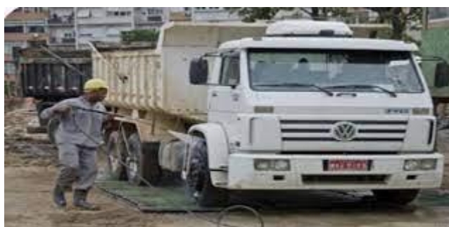
Figura 11 - Lavagem de Pneus em Obras para minimização de resíduos em vias
