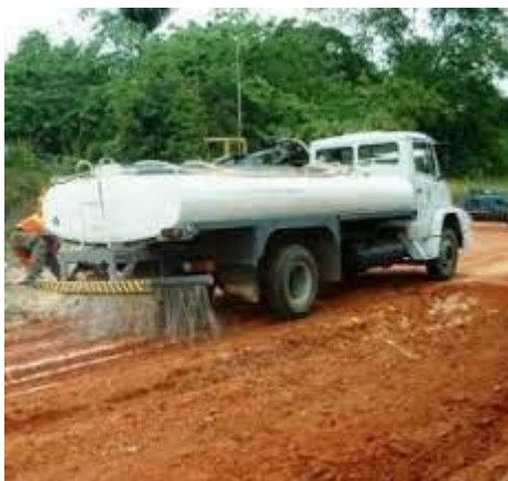
Figura 10 – Aspersão de Água em Caminhão Pipa para redução de particulados
