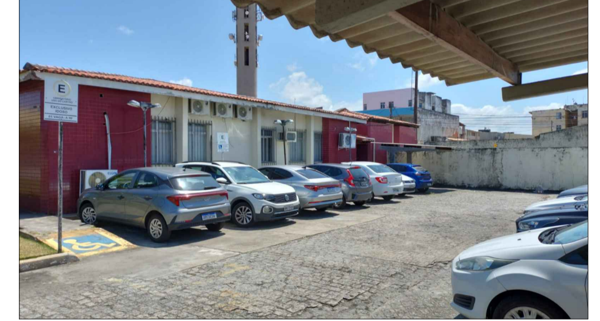
FOTO 03: ESTACIONAMENTO INTERNO (ATUAL)
