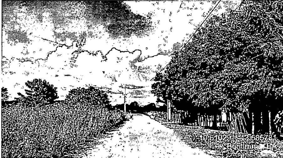
Foto 12: Situação do trecho meio da estrada que sofrerá intervenção
