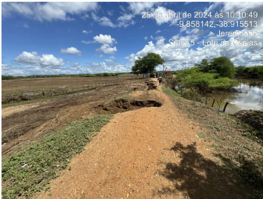
Figura 1 - Local onde a água danificou a estrada
