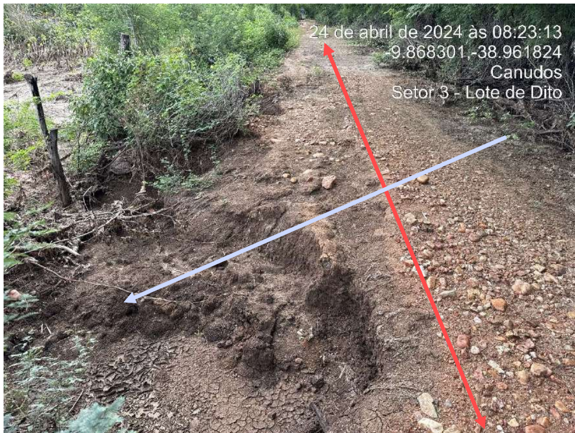
Figura 5 - – A linha vermelha indica a banca. A seta azul, representa o curso que o rio fez, cortando banca
