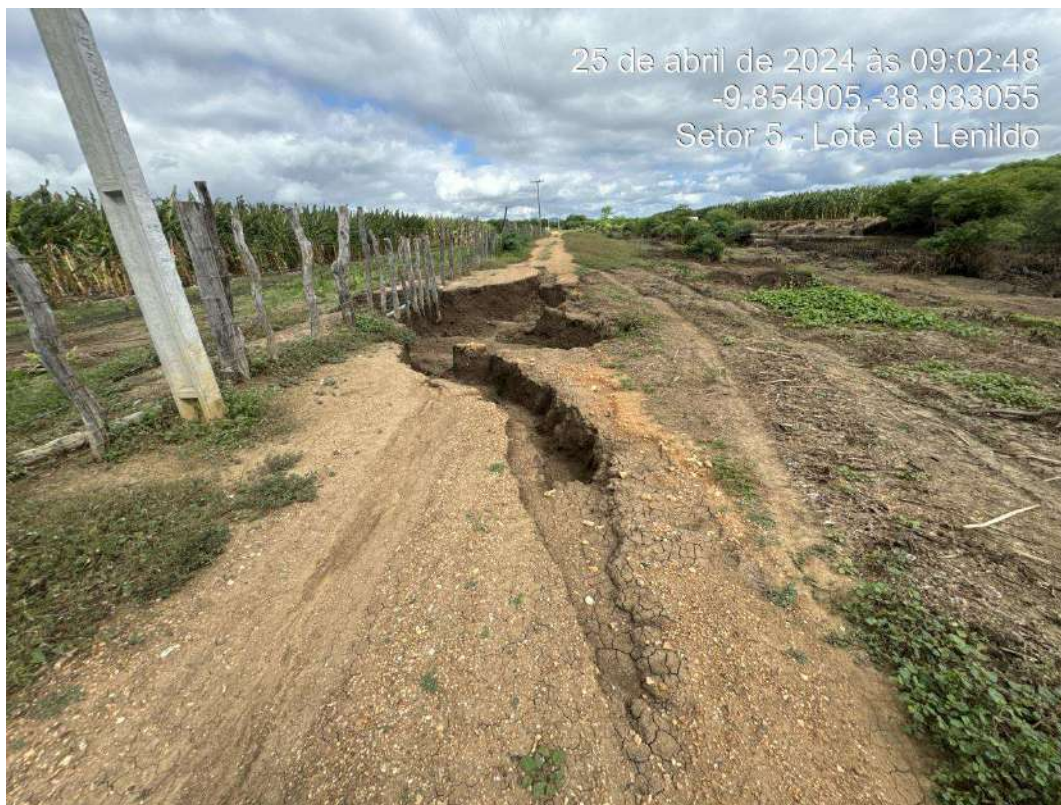
Figura 3— Estrada obstruída, por outro ângulo ela indica onde existia a banca. A seta azul, representa o curso que o rio fez, cortando a banca
