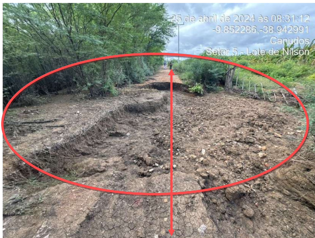
Figura 4 - – A linha vermelha indica o sentido da estrada. O ciuculo vermelho indica o local danificado na estrada
