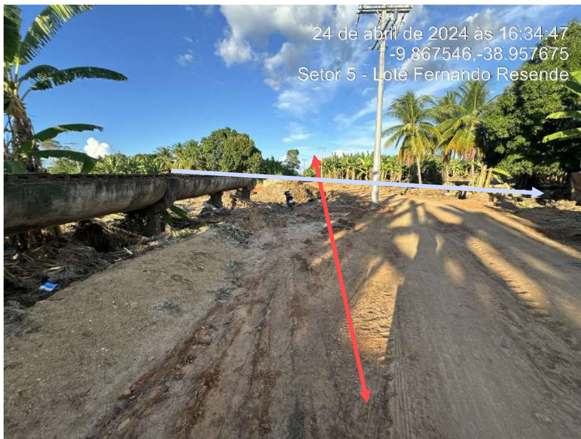
Figura 5 – A linha vermelha indica onde existia a estrada. A seta azul, representa o curso que o rio fez, cortando a estrada
