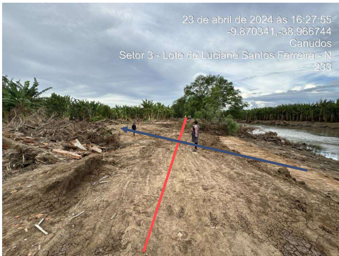
Figura 3 – A linha vermelha indica onde existia a estrada. A seta azul, representa o curso que o rio fez, cortando a estrada
