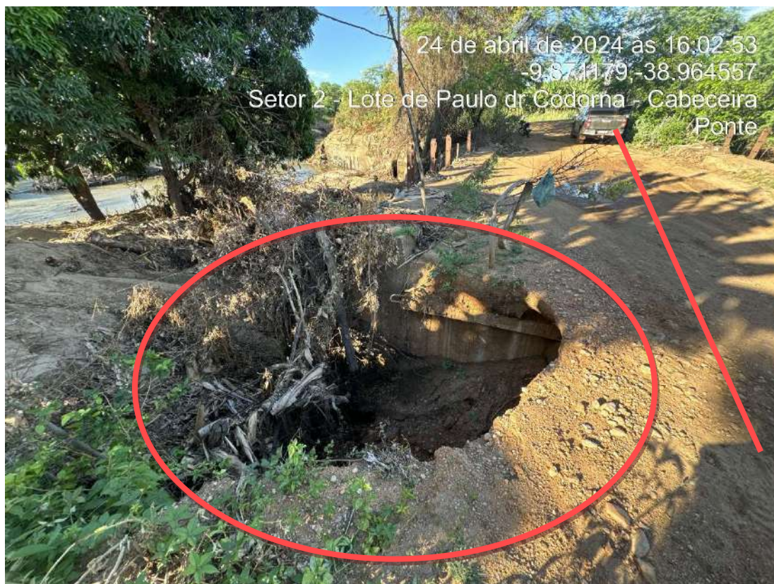
Figura 1 - Local onde levou material na cabeceira da ponte
