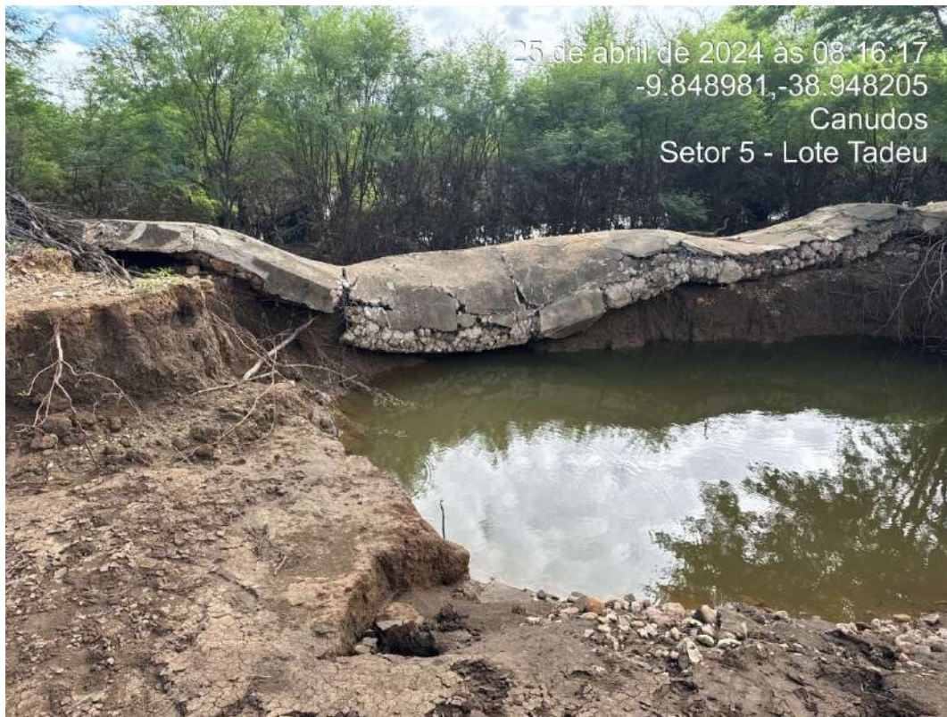
Figura 3– Danos na contenção de concreto
