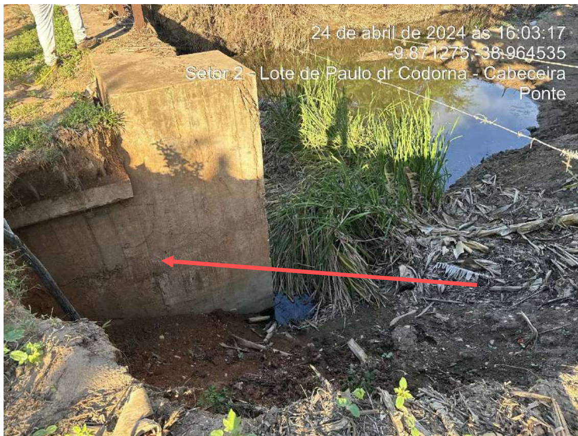
Figura 2 - Local onde levou material na cabeceira da ponte
