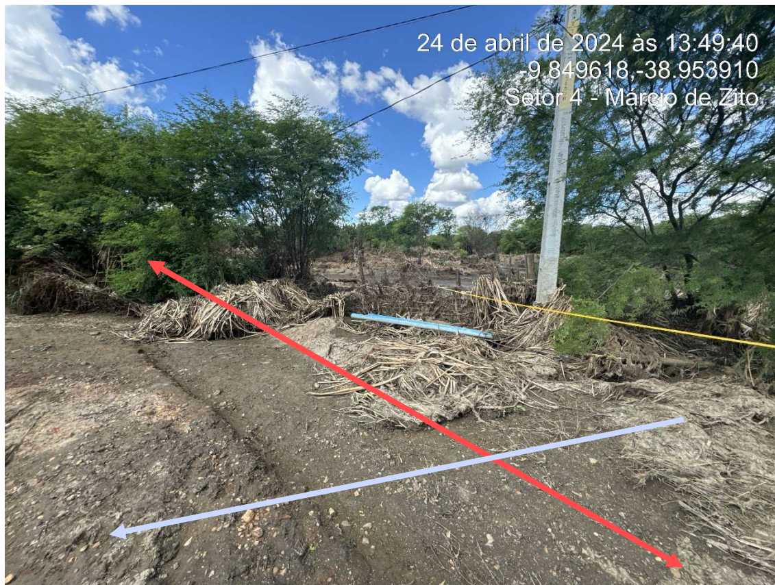
Figura 5 - A linha vermelha indica onde existia a banca. A seta azul, representa o curso que o rio fez, cortando a banca. Por ouro ângulo.
