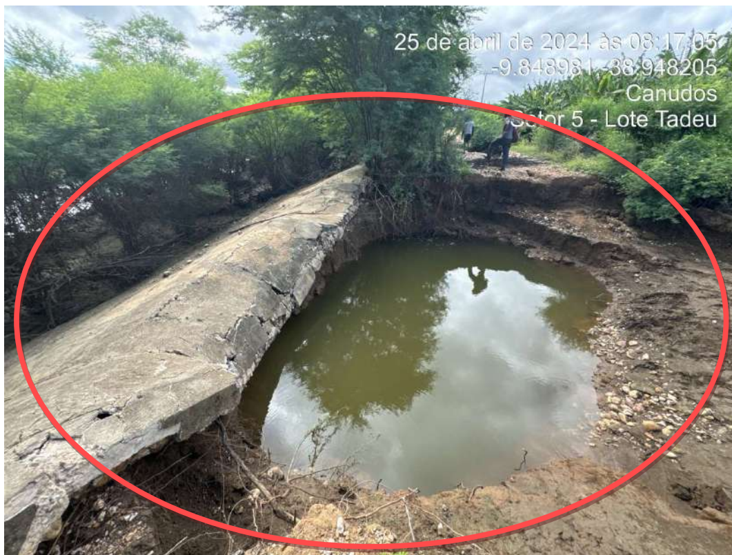
Figura 4 – problema na contenção de concreto e estrada danificada por outro ângulo
