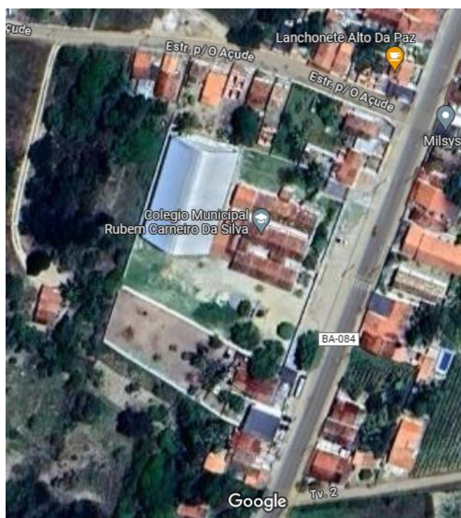
Figura 1 – Área onde está implantada a quadra
